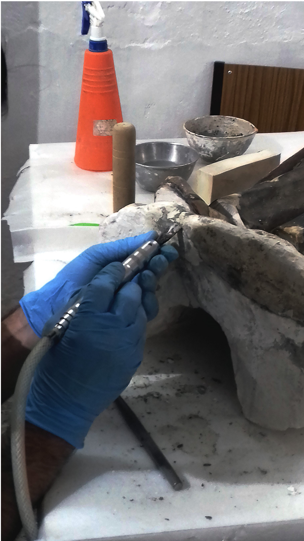
S. João Evangelista Remoção de cimento Convento de Cristo, Tomar © IPT
