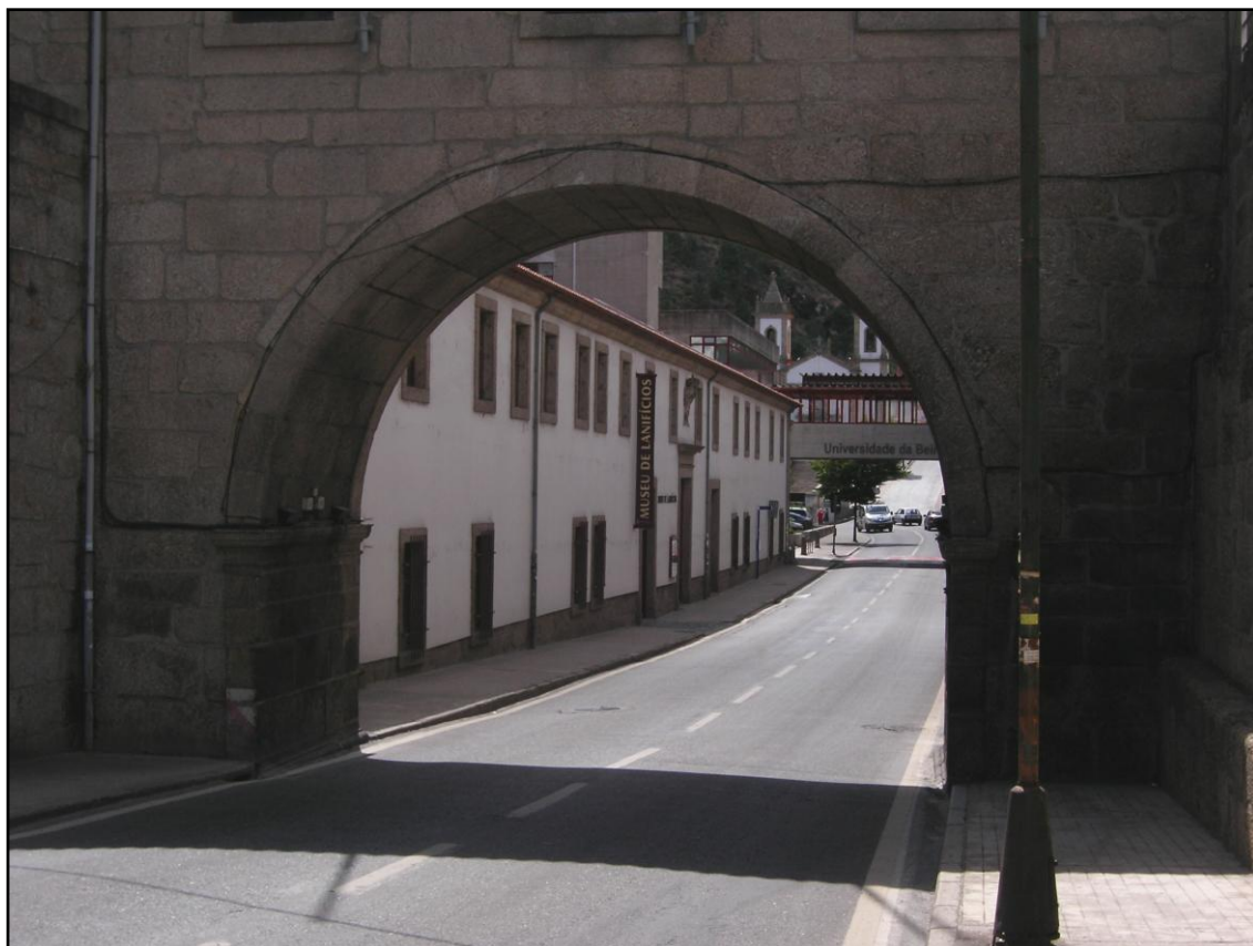
Figura 4 – Antiga Real Fábrica dos Panos / Hoje Universidade da Beira Interior (UBI) -Pólo I / Museu dos Lanifícios. (Pormenor do arco)
