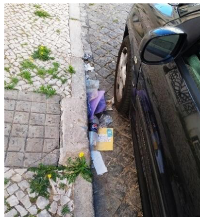
Figura 5. Sarjeta obstruída com detritos (Fonte: a autora)
