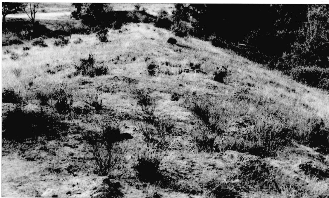
Photo 6 - Barrage de Monforte. Vue générale du remblai vers la rive droite.
