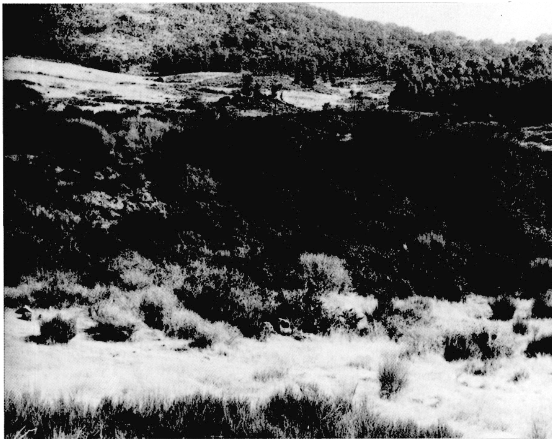
Photo 3 - Barrage de Rochoso. Vue générale du remblai de la rive droite.
