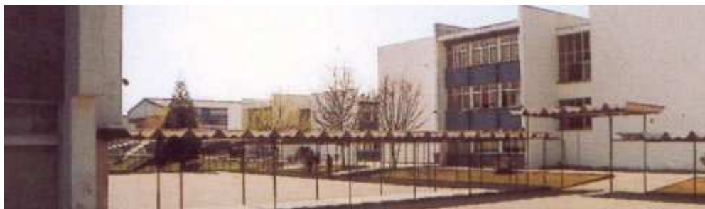
Figura 25 - Visualização do bloco B e das passagens cobertas com cimianto entre os vários blocos.
