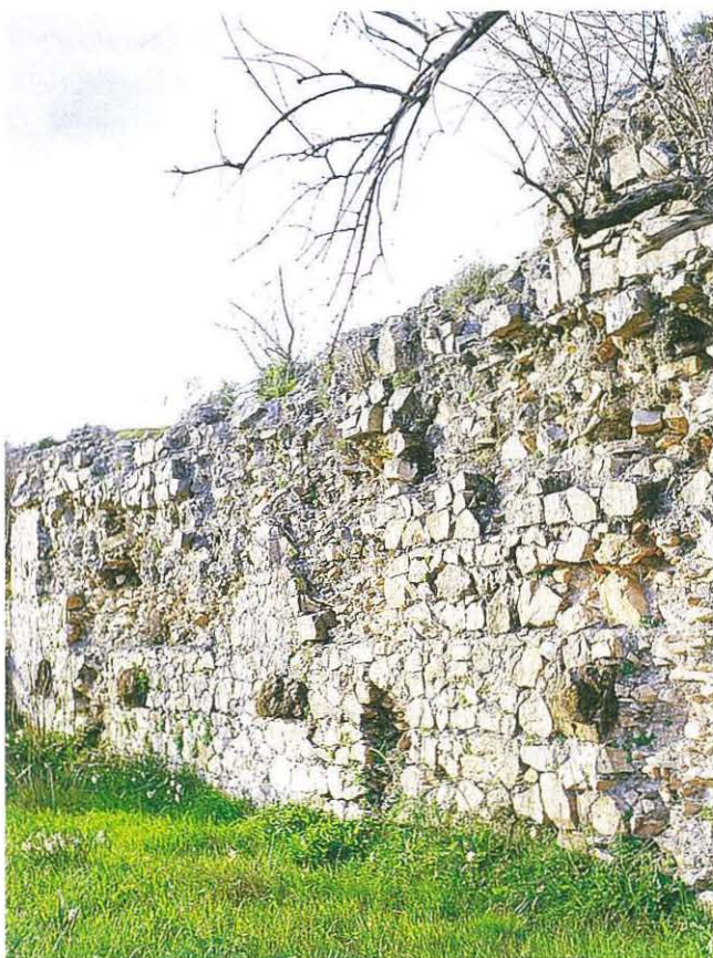
Barragem de Pisões (Beja). Vista de jusante.
