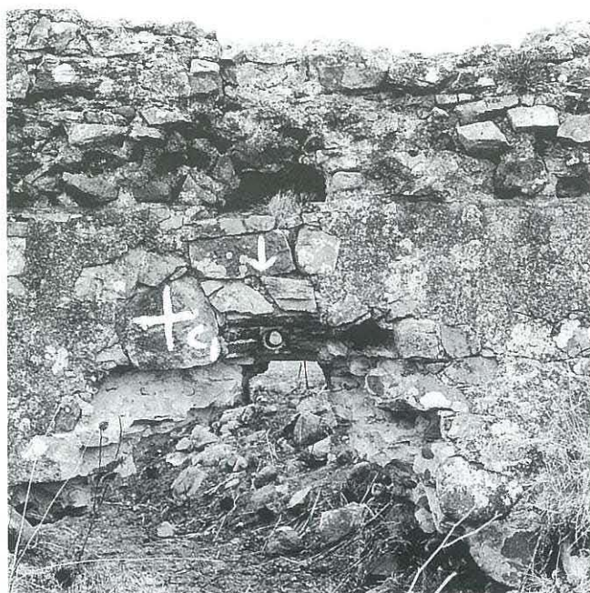
Barragem do Muro dos Mouros (Serpa). Tubo cerâmico de tomada da água.
