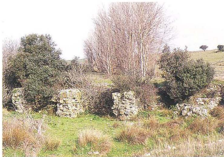
Barragem do Muro da Prega (Beja). Vista de jusante.
