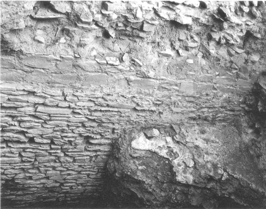
Figura 20 – Barragem do Álamo. Fino leito de argamassa amarelada, encostado ao paramento de montante da barragem, sobreposto por outro leito de argamassa mais esbranquiçada, embalando pequenos elementos de grauaque, observado no limite meridional da sondagem 4 (corte 3, ver Fig. 15). Foto J. L. C.
