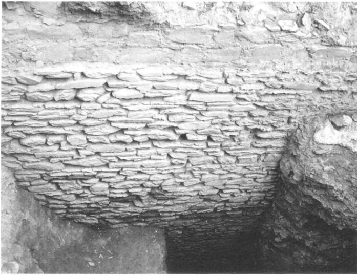
Figura 18 – Barragem do Álamo. Vista parcial do paramento de montante da barragem, observado em 2007 na sondagem 4, evidenciando o pequeno ressalto construtivo longitudinal, já anteriormente identificado, o qual poderá relacionar-se com a finalização de uma fase principal da construção da obra. Foto A. G.
