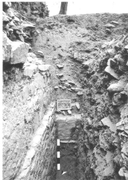
Figura 10 – Barragem do Álamo. Vista do corte sul da sondagem 1, observando-se, na sua parte inferior, o limite de uma estrutura de alvenaria, perpendicular ao paredão da barragem, fundada em sedimentos anteriormente depositados no fundo da albufeira. Foto A. G.
