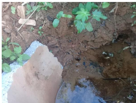
Figura A.I. 14 - Detalhe da mina de água próxima à ocupação
