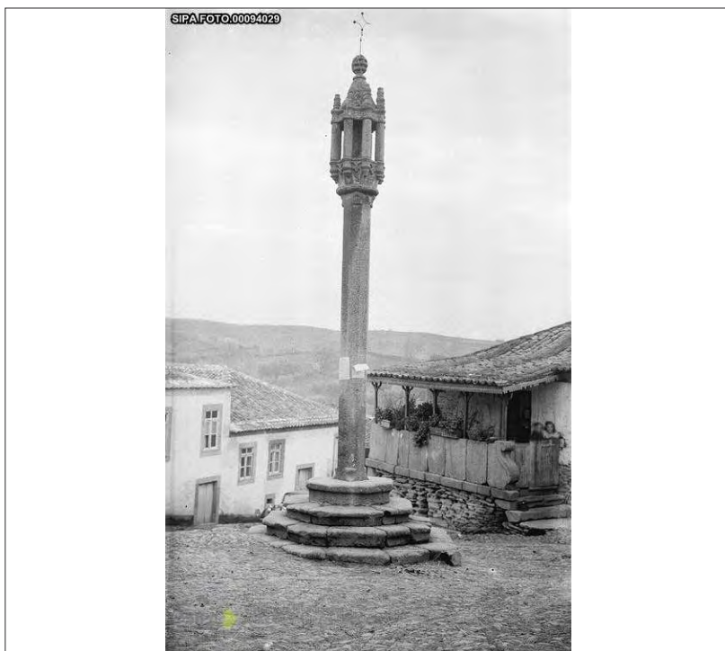
Fig. 6 - Pelourinho de Muxagata com anúncios afixados Fonte: IHRU, fundo "Direcção-Geral dos Edifícios e Monumentos Nacionais", série "Pelourinhos". Acessível através do SIPA – Sistema de Informação Para o Património Arquitectónico disponível na Internet em <URL: http://www.monumentos.pt >.
