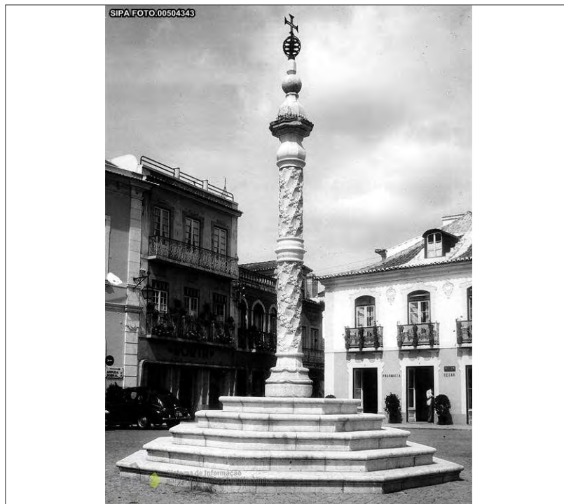
Fig. 40 - Pelourinho de Vila Franca de Xira depois de intervençionado
