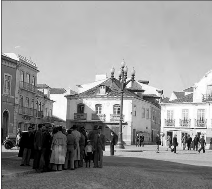
Fig. 39 - Largo da Câmara, em Vila Franca de Xira, antes de intervençionado
