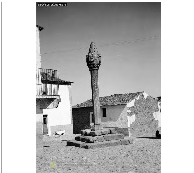
Fig. 23 - Pelourinho de Salvaterra do Extremo antes de intervençionado (1947)
