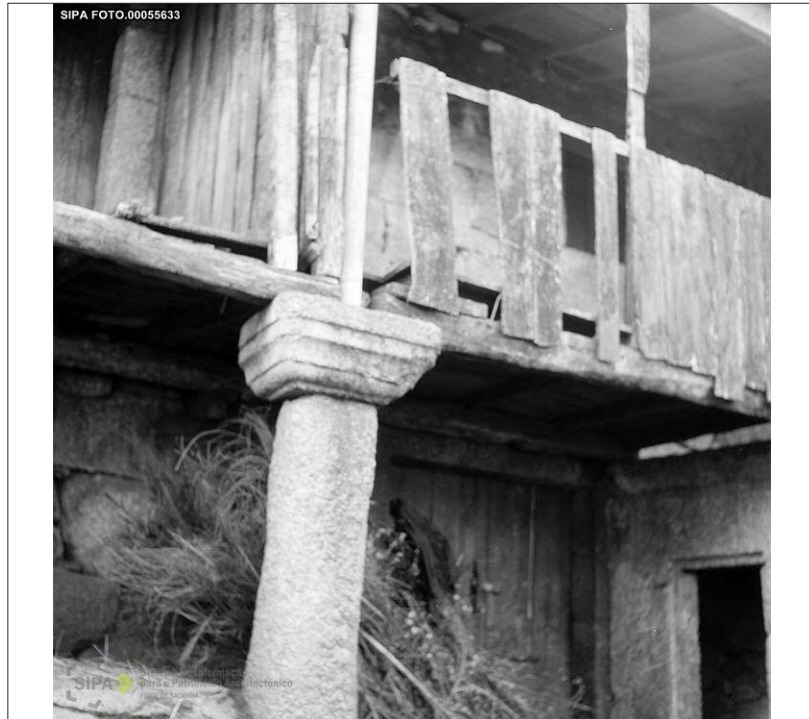
Fig. 13 - Fragmento (fuste) do pelourinho de Castro Laboreiro servindo de suporte a uma varanda (1967)
