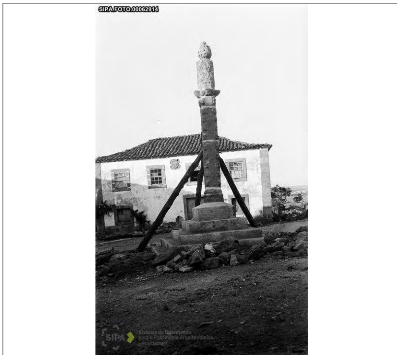
Fig. 2 - Trabalhos de consolidação do pelourinho de Algosó (1951) Fonte: IHRU, fundo "Direcção-Geral dos Edifícios e Monumentos Nacionais", série "Pelourinhos". Acessível através do SIPA – Sistema de Informação Para o Património Arquitectónico disponível na Internet em <URL: http://www.monumentos.pt >.
