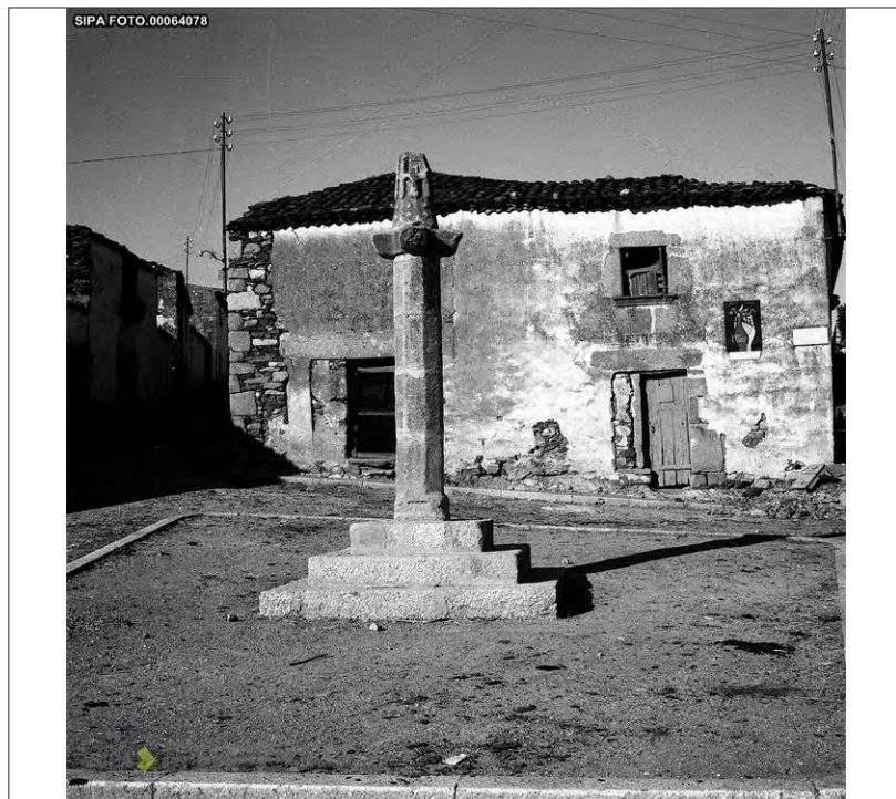
Fig. 44 - Pelourinho de Vimioso depois de intervençionado (1959) Fonte: IHRU, fundo "Direcção-Geral dos Edifícios e Monumentos Nacionais", série "Pelourinhos". Acessível através do SIPA – Sistema de Informação Para o Património Arquitectónico disponível na Internet em <URL: http://www.monumentos.pt >.
