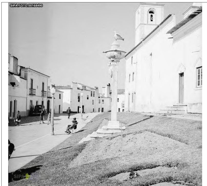
Fig. 4 - Pelourinho de Avis depois de intervençionado (1953) Fonte: IHRU, fundo "Direcção-Geral dos Edifícios e Monumentos Nacionais", série "Pelourinhos". Acessível através do SIPA – Sistema de Informação Para o Património Arquitectónico disponível na Internet em <URL: http://www.monumentos.pt >.
