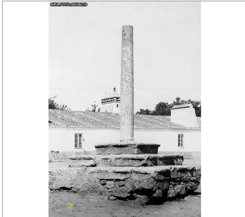
Fig. 1 - Pelourinho de Água de Peixes antes de intervençionado Fonte: IHRU, fundo "Direcção-Geral dos Edifícios e Monumentos Nacionais", série "Pelourinhos". Acessível através do SIPA – Sistema de Informação Para o Património Arquitectónico disponível na Internet em <URL: http://www.monumentos.pt >.
