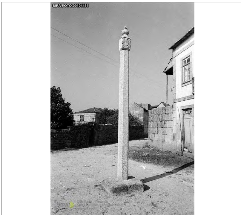
Fig. 28 - Pelourinho de Seixo da Beira depois de intervençionado Fonte: IHRU, fundo "Direcção-Geral dos Edifícios e Monumentos Nacionais", série "Pelourinhos". Acessível através do SIPA – Sistema de Informação Para o Património Arquitectónico disponível na Internet em <URL: http://www.monumentos.pt >.
