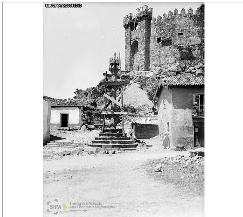
Fig. 8 - Trabalhos de conservação do pelourinho de Penedono Fonte: IHRU, fundo "Direcção-Geral dos Edifícios e Monumentos Nacionais", série "Pelourinhos". Acessível através do SIPA – Sistema de Informação Para o Património Arquitectónico disponível na Internet em <URL: http://www.monumentos.pt >.
