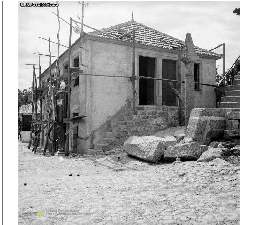
Fig. 3 - Aplicação de telha tipo “marseille” na zona de protecção do pelourinho de Rossas (1953)
