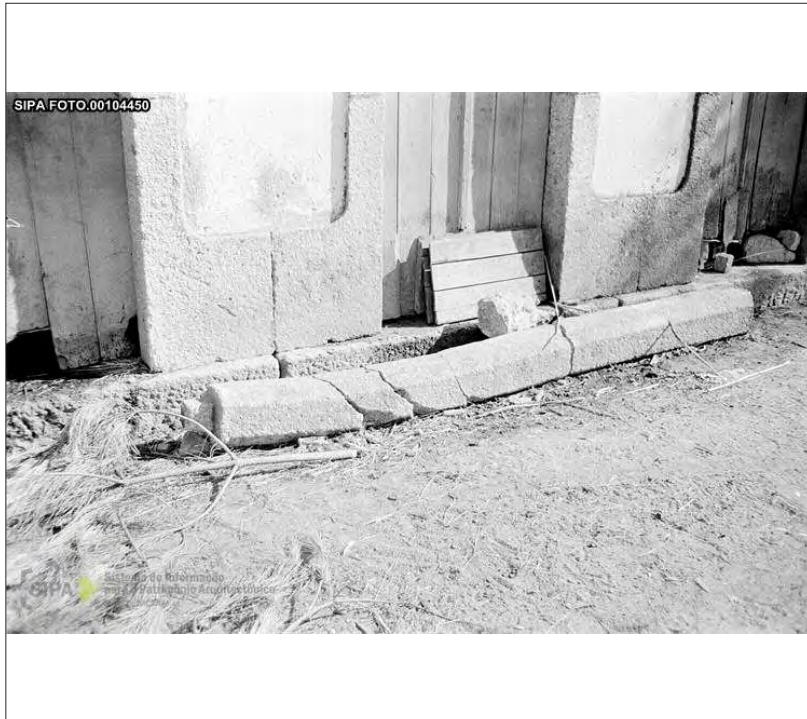
Fig. 27 - Pelourinho de Seixo da Beira antes de intervençionado Fonte: IHRU, fundo "Direcção-Geral dos Edifícios e Monumentos Nacionais", série "Pelourinhos". Acessível através do SIPA – Sistema de Informação Para o Património Arquitectónico disponível na Internet em <URL: http://www.monumentos.pt >.
