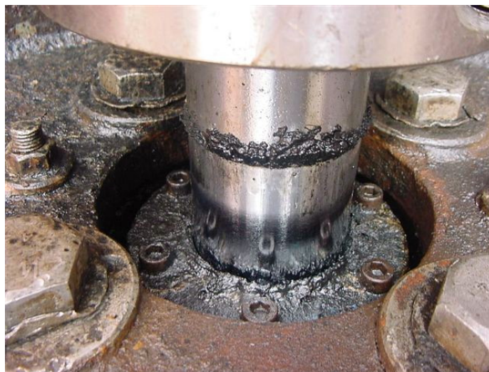
Fig. 5.15 – Início de falha dos vedantes do cilindro óleo-hidráulico
