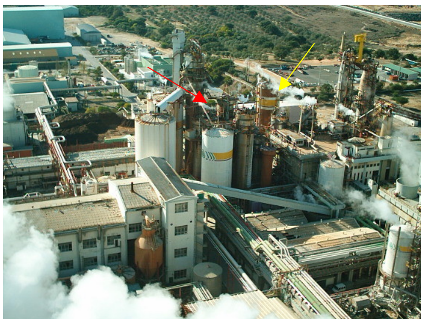
Fig. 4.5 – Vista da área fabril do branqueamento da pasta
