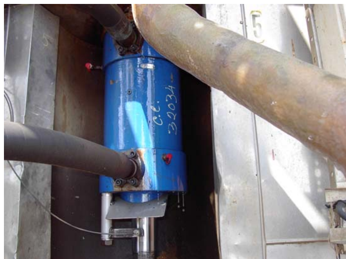
Fig. 5.13 – Cilindro óleo-hidráulico do sistema de elevação dos crivos
