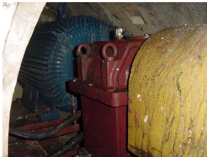
Fig. 5.18 – Redutor de transmissão entre o motor e a bomba MC
