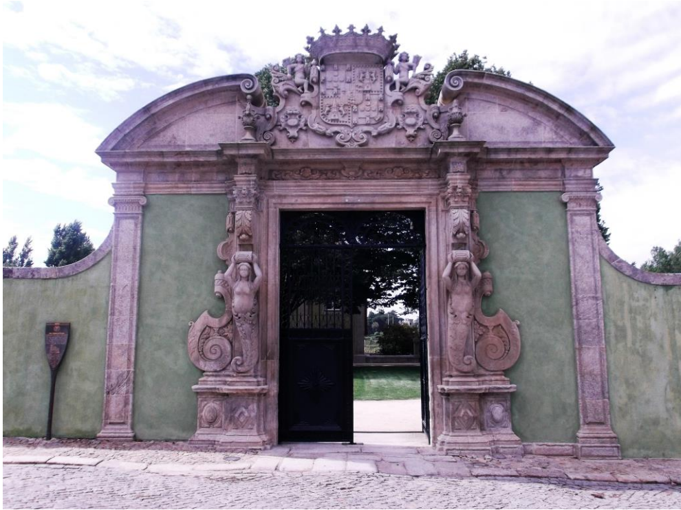
2. Portal após o restauro
