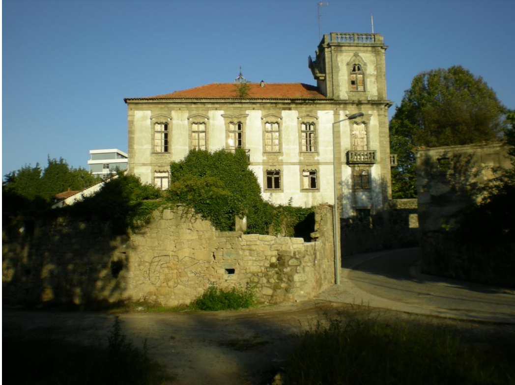
3. Quinta da Prelada fachada poente antes do restauro (2010)
