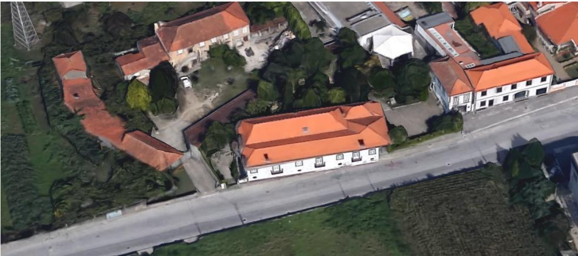
1. Fotografia aérea do Imóvel. Levantamento Fotográfico da Microsoft - Google Maps (Mai. 2016).
