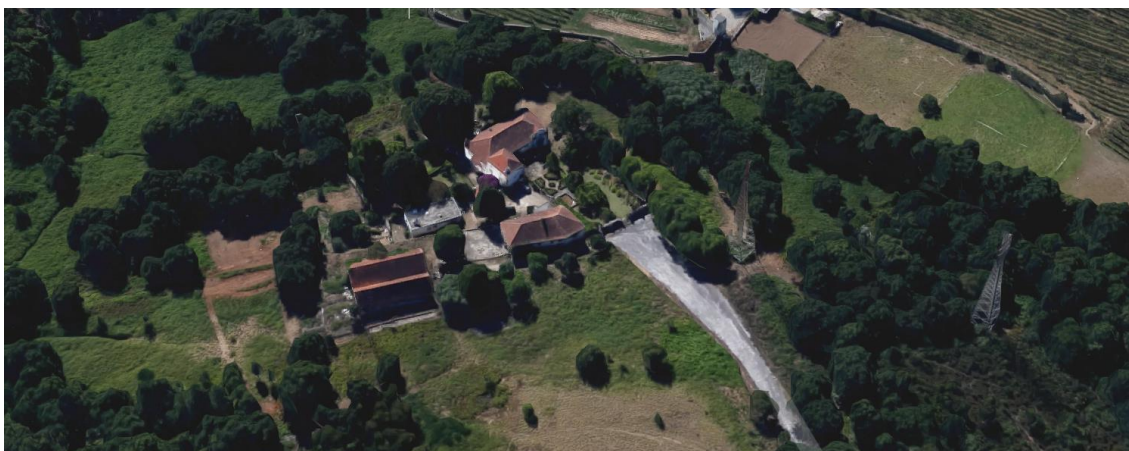
1. Fotografia aérea do Imóvel. Levantamento Fotográfico da Microsoft - Google Maps (Mai. 2016).
