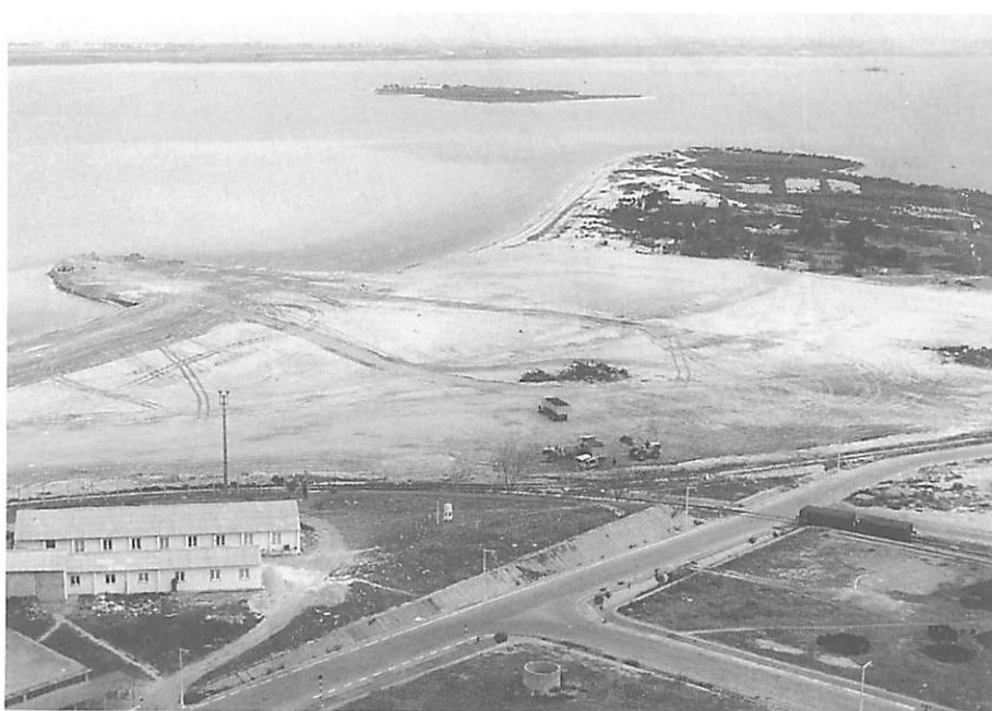
FIGURA 5 – Vista aérea da Ponta da Passadeira, em 1973, aquando dos trabalhos de terraplenagens para a construção da Fisipe. Em penúltimo plano, a ilha do Rato. Arquivo fotográfico da Quimiparque
