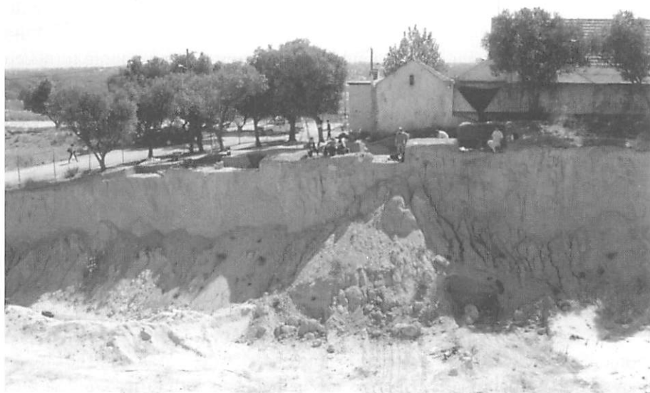
FIGURA 14 – Aspecto da Quinta de S. Pedro e das escavações arqueológicas na necrópole sobranceira ao talude criado pelas terraplenagens
