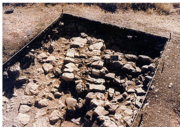
Fig. 31 Leceia: Cabana A, do lado direito de troço de muralha, observando-se no seu interior duas estruturas de combustão, A1 e A2 (ver Fig. 27).
