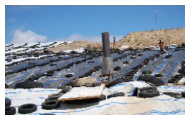
Impermeabilização das células com resíduos
