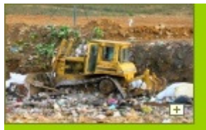
g) Acondicionamento dos RU's
