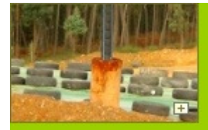
c) Drenagem do biogás
