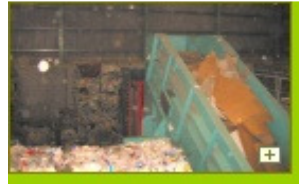
d) Compactação e enfardamento
