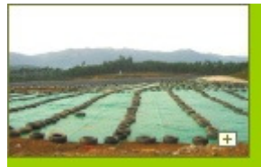
b) Drenagem de lixiviado
