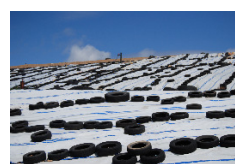
Impermeabilização das células com resíduos
