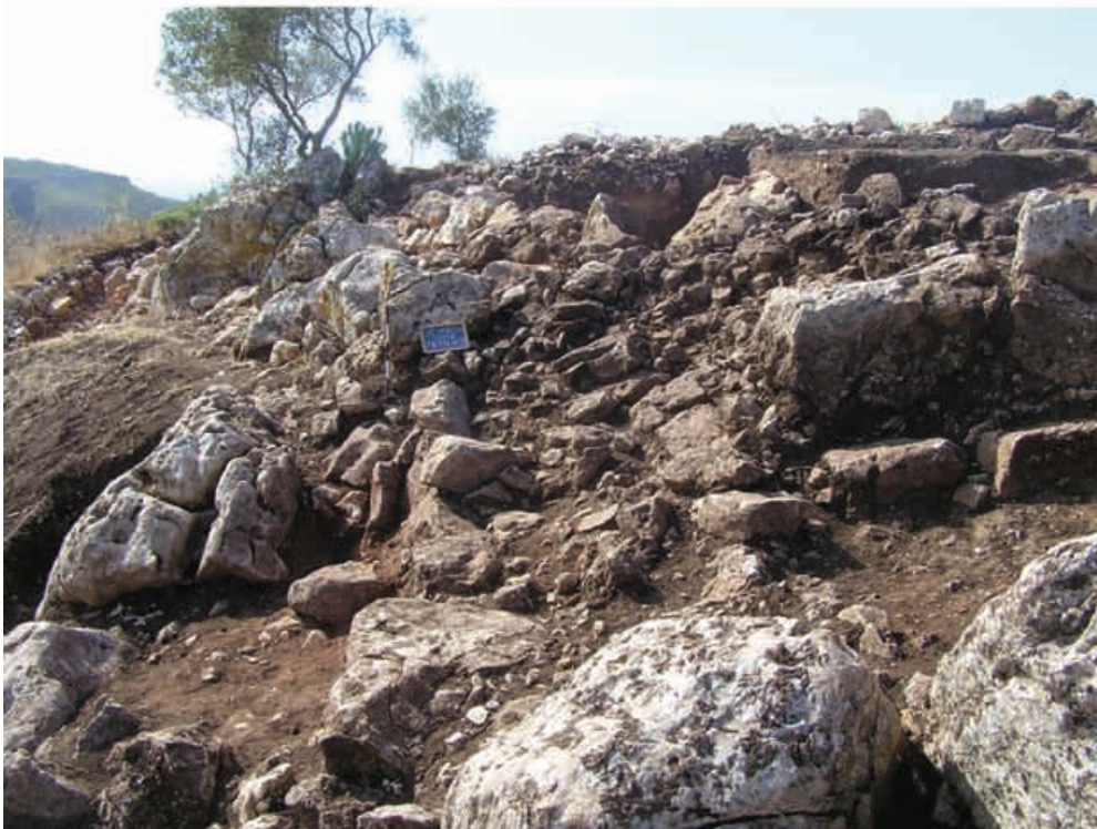
Fig. 35 – Outeiro Redondo. Dois aspectos da técnica construtiva da Muralla G, evidenciando-se alinhamentos de grandes blocos, definindo os paramentos interno e externo, com enchimento de blocos de menores dimensões. Em cima: foto do sector da Muralla G voltado a sul, escavado em 2014. Em baixo: foto do sector da Muralla G com orientação Norte-Sul, do lado nascente da área escavada em 2015, edificado entre afloramentos rochosos (fotos de J. L. Cardoso).
