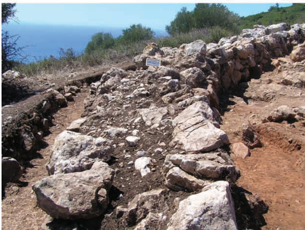
Fig. 32 – Outeiro Redondo. Em cima: vista do lado interno de sector da Muralha G voltado a Sul, posta a descoberto em 2013, evidenciando-se a má qualidade do aparelho construtivo do paramento, constituído por blocos heterométricos e muito irregularmente dispostos, assentes ora no substrato natural de “terra rossa”, ora em depressões preenchidas com espólios do final do Calcolítico Inicial. Em baixo: vista do mesmo sector da Muralha G, cuja escavação se concluiu em 2014, arqueando progressivamente, acompanhando a topografia do terreno, evidenciando-se a respectiva técnica construtiva (fotos de J. L. Cardoso).
