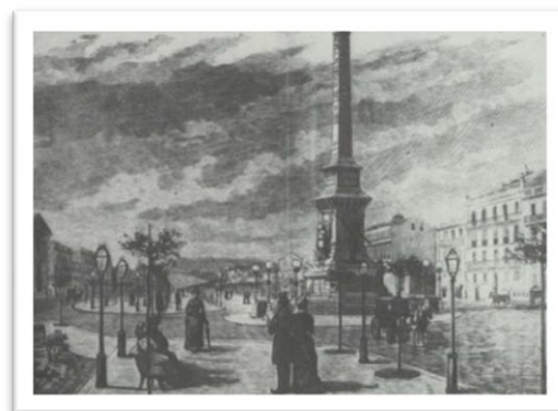
Fig. nº 23 - Praça dos Restauradores 19 após a demolição do Passeio Público . Monumento inaugurado a 28 de Abril de 1886
