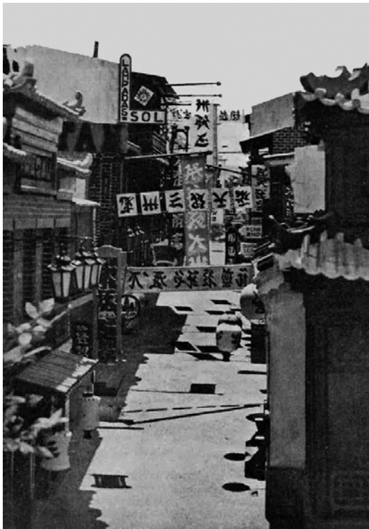
FIGURA 25 | SECÇÃO COLONIAL [RUA DE MACAU] FOTO: REVISTA DOS CENTENÁRIOS. 1940. ARQUIVO FOTOGRÁFICO DA CÂMARA MUNICIPAL DE LISBOA
