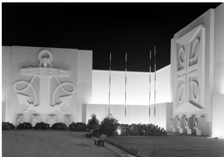
FIGURA 39 | PAVILHÃO DOS DESCOBRIMENTOS PROJECTO: PARDAL MONTEIRO FOTO: MÁRIO NOVAIS. 1940. ARQUIVO DE ARTE DO SERVIÇO DE BELAS ARTES DA FUNDAÇÃO CALOUSTE GULBENKIAN
