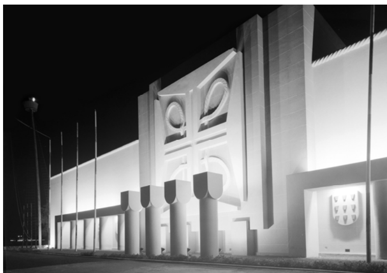
FIGURA 38 | PAVILHÃO DOS DESCOBRIMENTOS [FACHADA SUL]
