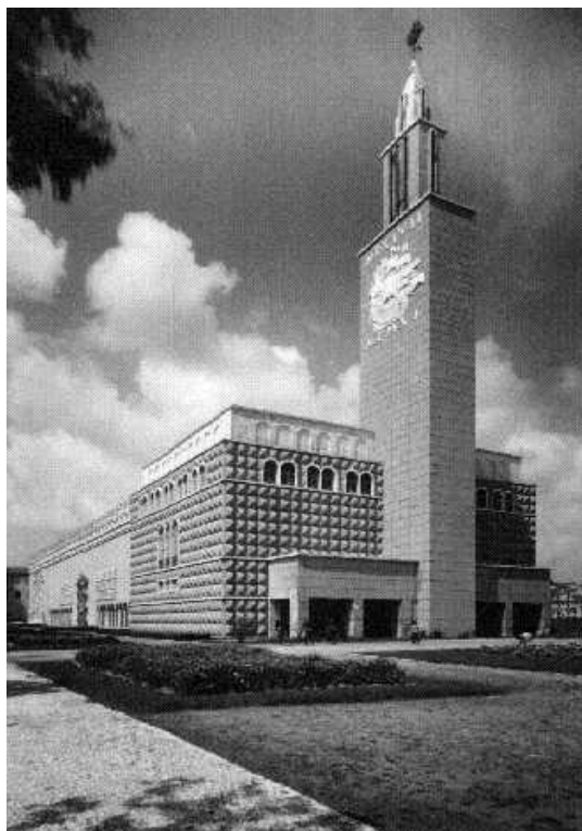
FIGURA 47 | PAVILHÃO DA HONRA E DE LISBOA PROJECTO: CRISTINO DA SILVA FOTO: KURT PINTO. 1940. ARQUIVO FOTOGRÁFICO DA CÂMARA MUNICIPAL DE LISBOA
