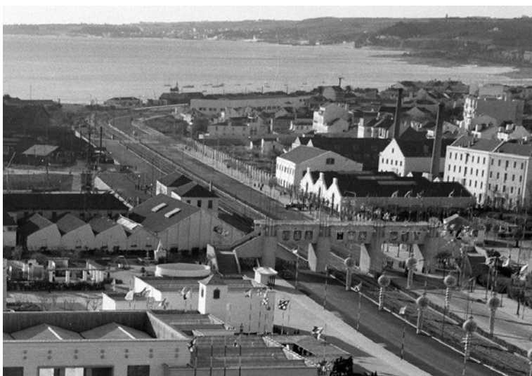
FIGURA 6 | PORTA DA RESTAURAÇÃO.
