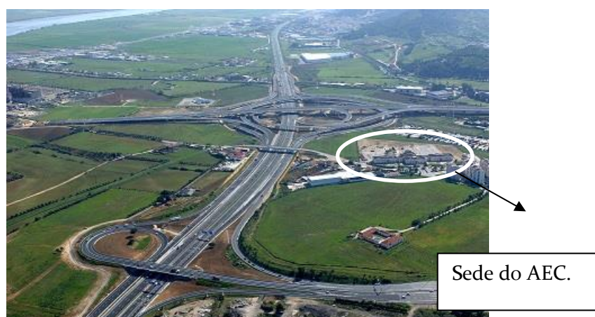
FIGURA 2–NÓ DO CARREGADO ENTRE AS AUTO-ESTRADAS, A1 E A10, JUNTO DA ESCOLA SEDE DO AEC.
