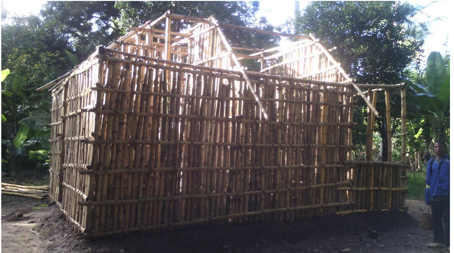
Uma casa em construção no Baixo Licungo (Nante – Maganja da Costa) – 2018
