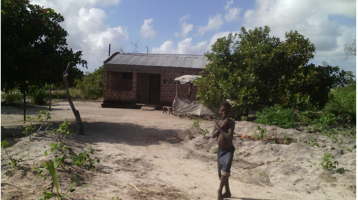
Modelo de habitação do centro de realojamento de Mussaia – Nante - Maganja da Costa - 2018
