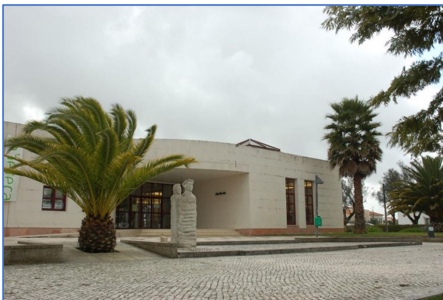
Figura 4.4 – Edifício sede do CLA de Cantanhede
