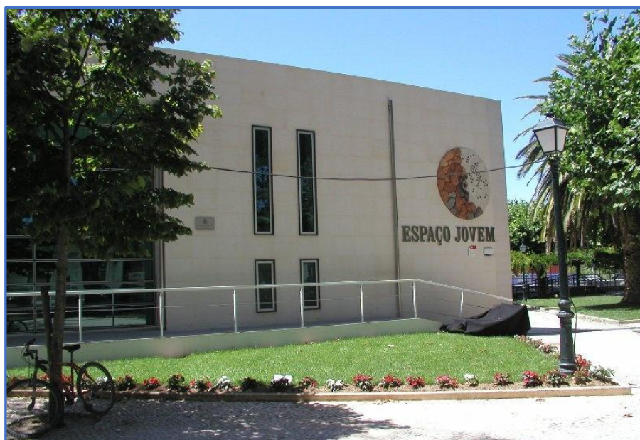
Figura 4.6 – Edifício sede do CLA de Porto de Mós
