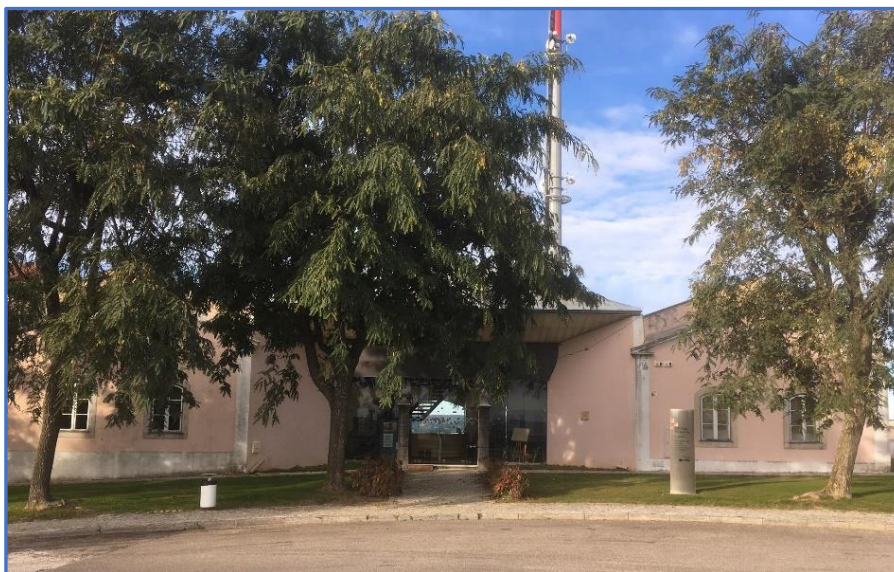
Figura 4.5 - Edifício sede do CLA de Abrantes
