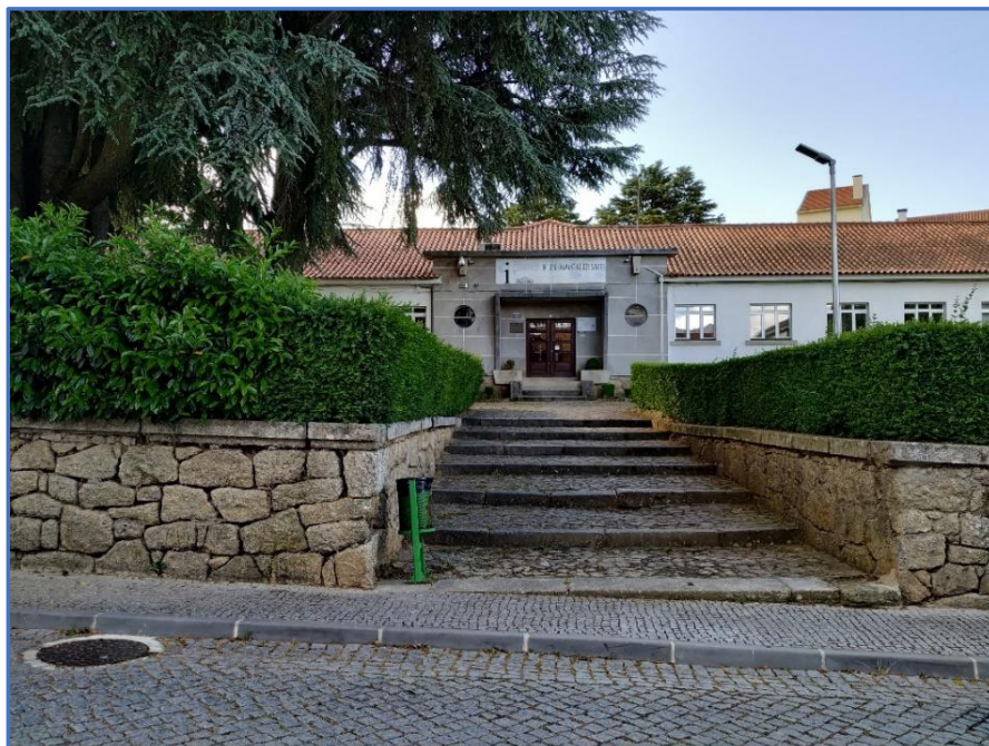
Figura 4.3 – Edifício sede do CLA do Sabugal
