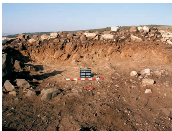
Fig. 19 Moita da Ladra. Vista externa frontal da Muralha A, entre a Torre B e a Torre C (ver Fig. 17). Observe-se o embasamento dos blocos calcários que constituem o paramento externo directamente no substrato basáltico alterado, recorrendo-se nalguns casos, para melhorar a estabilidade, à interposição de pequenas cunhas de calcário.
