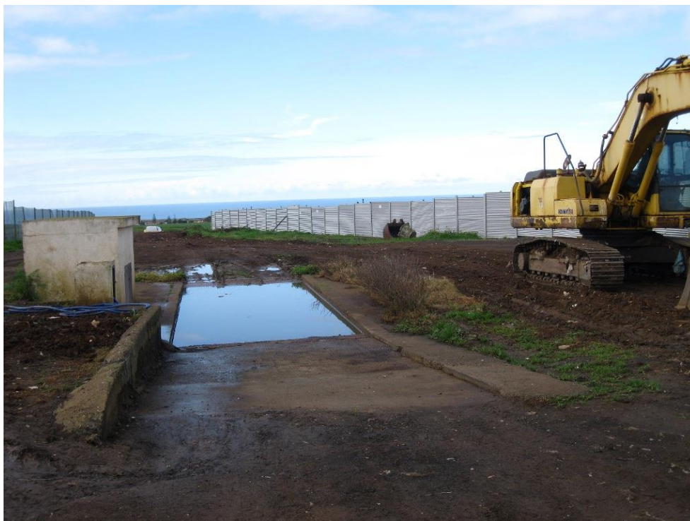
Figura 1.13. Lavagem de rodados do Aterro Controlado de Santa Maria.
