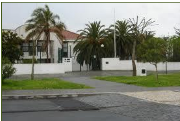
Figura 5 - Fachada da Escola Secundária das Laranjeiras
