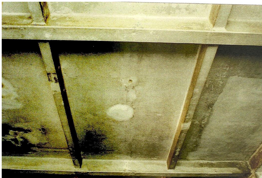
Foto 29 – Piso 4, ala norte, tecto, cruzamento de pilar e vigas, 1997 (fonte: Direcção Regional de Cultura de Lisboa e Vale do Tejo, processo de classificação DRL-92/3(2); foto nº 131, rolo 1; autor: arq. José Russo)
