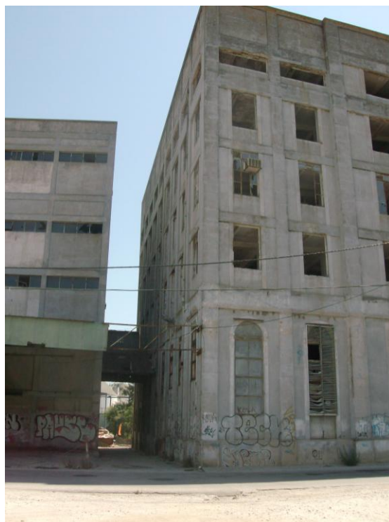
Foto 26 – Outra perspectiva da fábrica e da estrutura de apoio à armazenagem e ensaque na Rua Manuel José Gomes, Agosto 2010 (Autora: Conceição Toscano)
