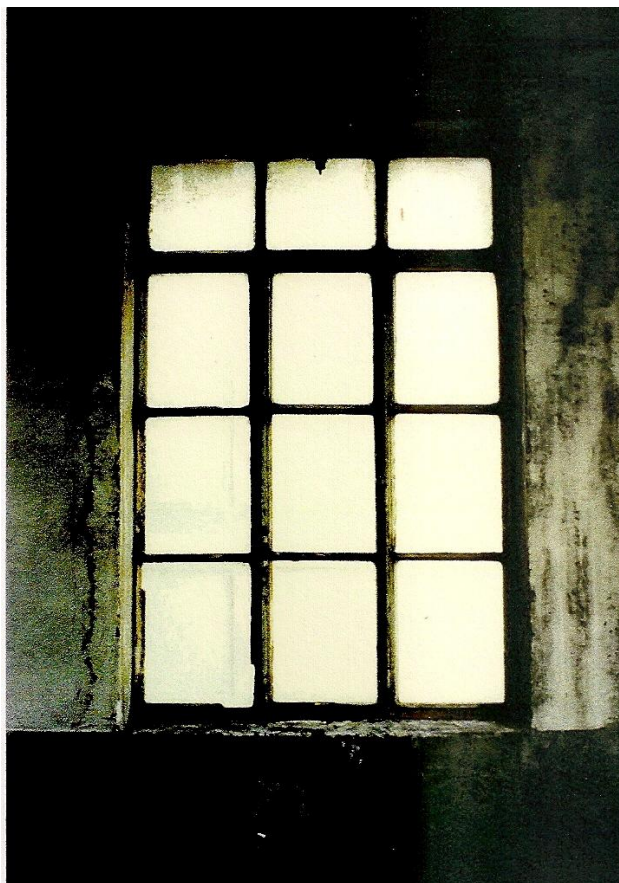
Foto 27 – Piso 4, janela na fachada norte, 1997 (fonte: Direcção Regional de Cultura de Lisboa e Vale do Tejo, processo de classificação DRL-92/3(2); foto nº 127, rolo 1; autor: arq. José Russo)
