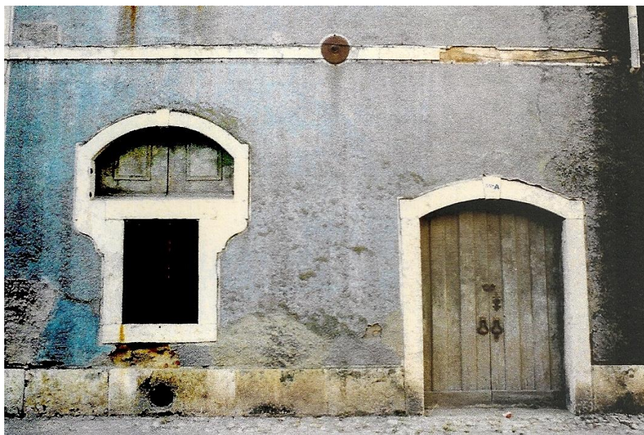
Foto 67 – Edifício na Rua Manuel José Gomes: porta e janela de bandeira imposta, 1997 (fonte: Direcção Regional de Cultura de Lisboa e Vale do Tejo, processo de classificação DRL-92/3(2); foto nº 432, rolo 4; autor: arq. José Russo)
