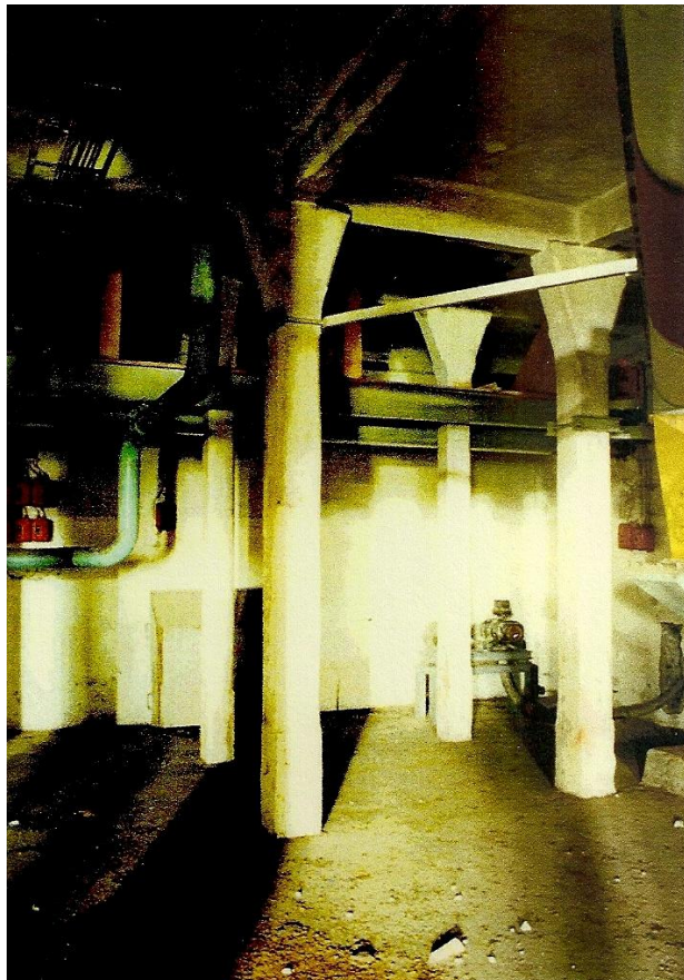
Foto 47 – Piso 0, ala sul, pilares, 1997 (fonte: Direcção Regional de Cultura de Lisboa e Vale do Tejo, processo de classificação DRL-92/3(2); foto n° 302, rolo 3; autor: arq. José Russo)
