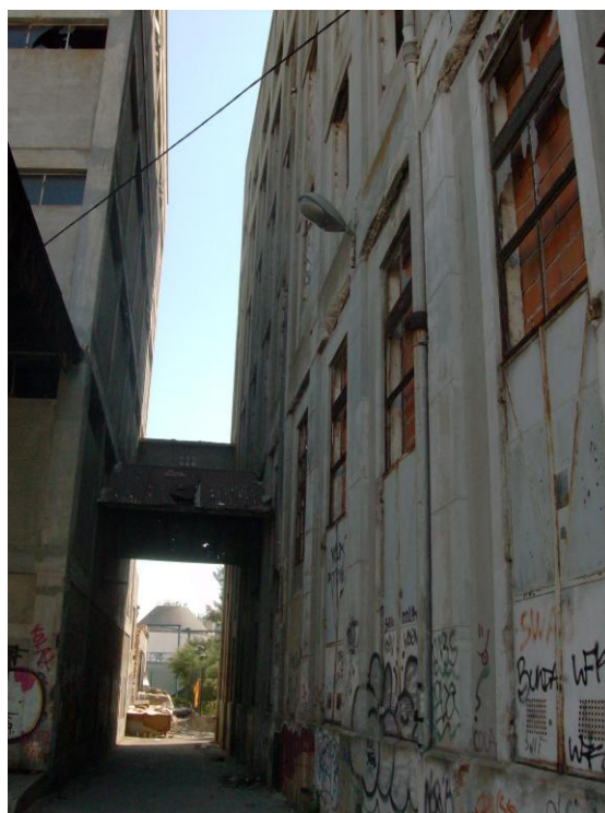
Foto 8 – Passagem de ligação entre os dois edifícios; por esta passagem aérea passava a farinha após a moagem na fábrica (edifício situado à direita da fotografia); também por aqui se acedia da Rua Manuel José Gomes ao Cais da Margueira, Agosto 2010 (Autora: Conceição Toscano)
