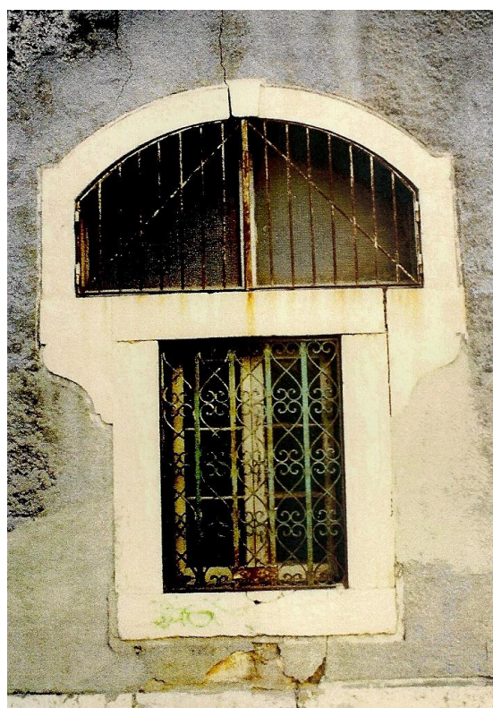
Foto 68 – Edifício na Rua Manuel José Gomes: janela de bandeira imposta, 1997 (fonte: Direcção Regional de Cultura de Lisboa e Vale do Tejo, processo de classificação DRL-92/3(2); foto nº 431, rolo 4; autor: arq. José Russo)
