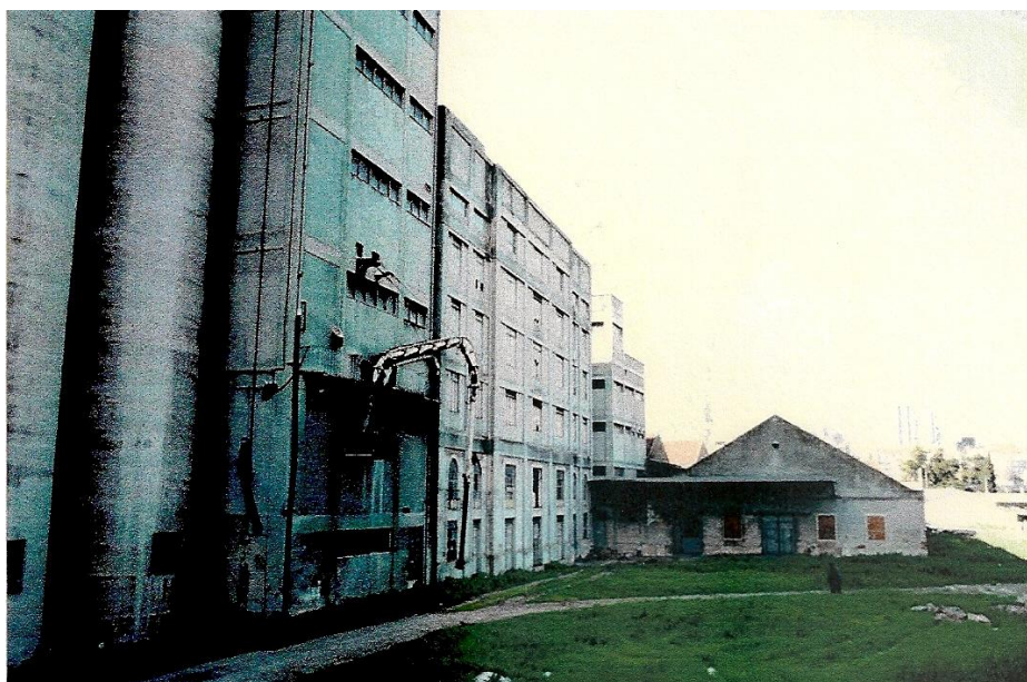
Foto 55 – Vista da fachada principal, silo e armazéns, 1997 (fonte: Direcção Regional de Cultura de Lisboa e Vale do Tejo, processo de classificação DRL-92/3(2); foto nº 336, rolo 3; autor: arq. José Russo)
