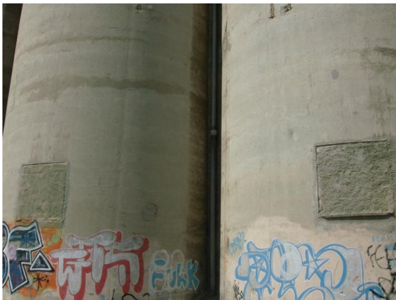
Foto 15 – Silos, na situação da posição do antigo cais – nas janelas fechadas estavam situados computadores: eram três encarregados, cada turno tinha o seu encarregado; aqui tinham lugar as diversas operações administrativas ligadas ao abastecimento da matéria-prima da fábrica (cereal – trigo, centeio), Agosto 2010 (Autora: Conceição Toscano)
