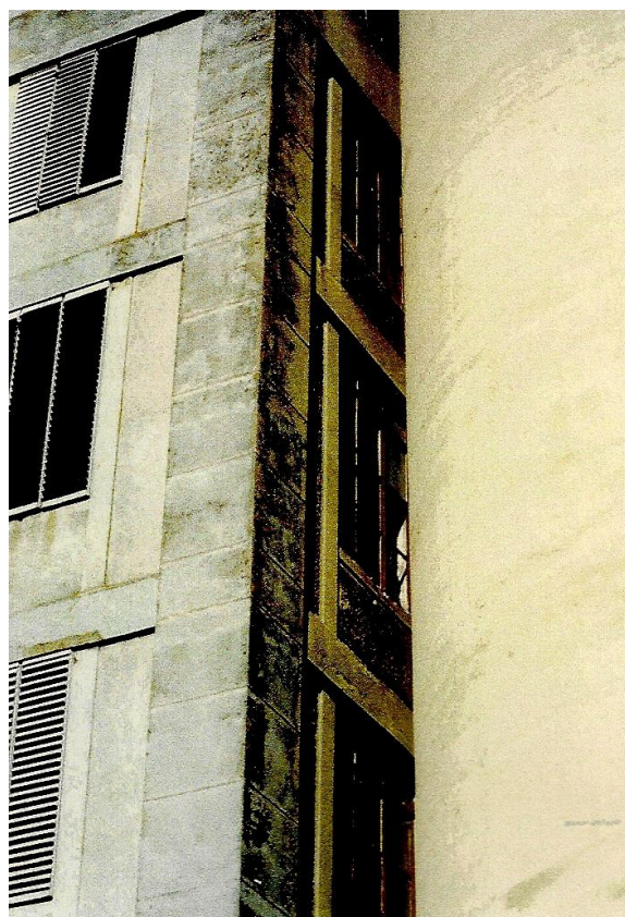
Foto 54 – Fachada sul, vista em pormenor e cunhal, 1997 (fonte: Direcção Regional de Cultura de Lisboa e Vale do Tejo, processo de classificação DRL-92/3(2); foto nº 327, rolo 3; autor: arq. José Russo)
