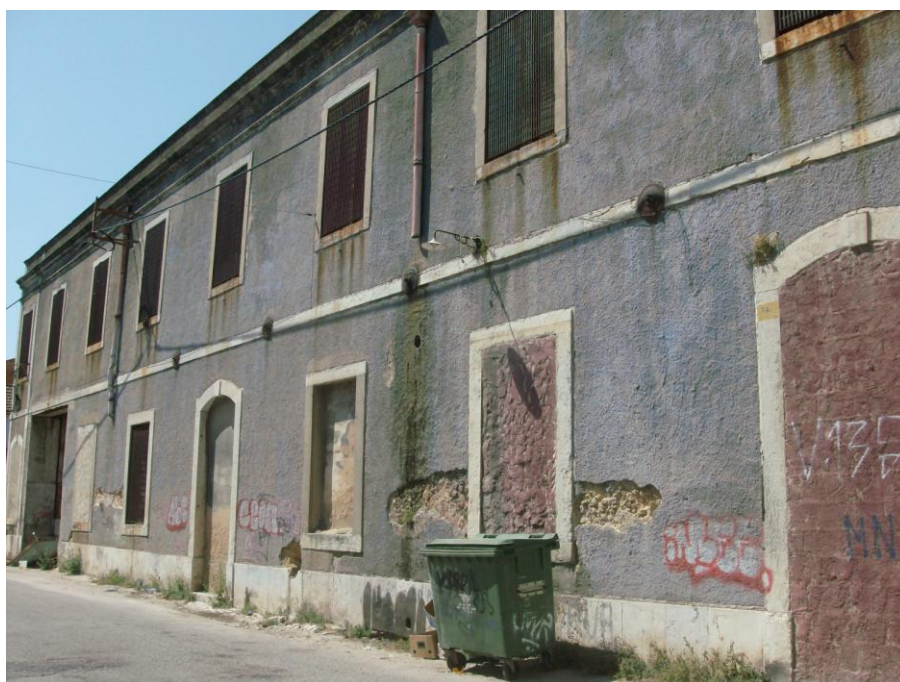
Foto 22 – Extremo do edifício da foto anterior; aí situava-se a oficina de mecânica, onde se reparavam carrinhas e camiões. “Foi a primeira a fechar”, Agosto 2010 (Autora: Conceição Toscano)
