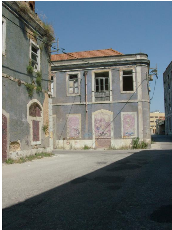
Foto 23 – Ao centro, vemos a fachada lateral do edifício que albergava no piso inferior a serralharia e no piso superior o laboratório de análises. Na esquerda da foto vemos o início da estrutura onde se situavam os balneários no piso térreo e por cima o refeitório. “A serralharia e a carpintaria fecharam após a oficina de mecânica. Mais tarde a bolacha. Só ficou a moagem.” (Armindo S. Dionísio), Agosto 2010 (Autora: Conceição Toscano)
