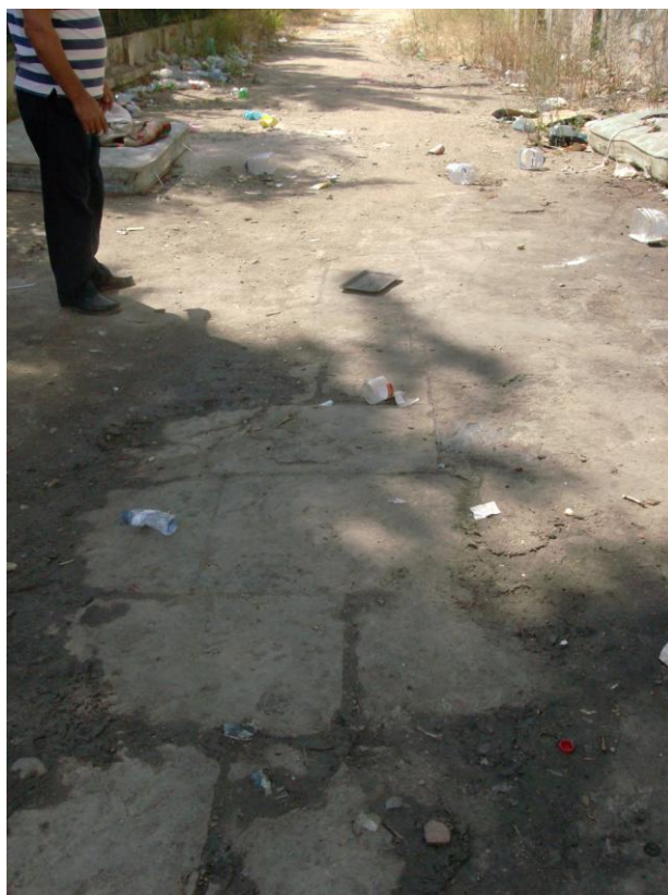
Foto 12 – Pavimento do antigo cais, Agosto 2010 (Autora: Conceição Toscano)
