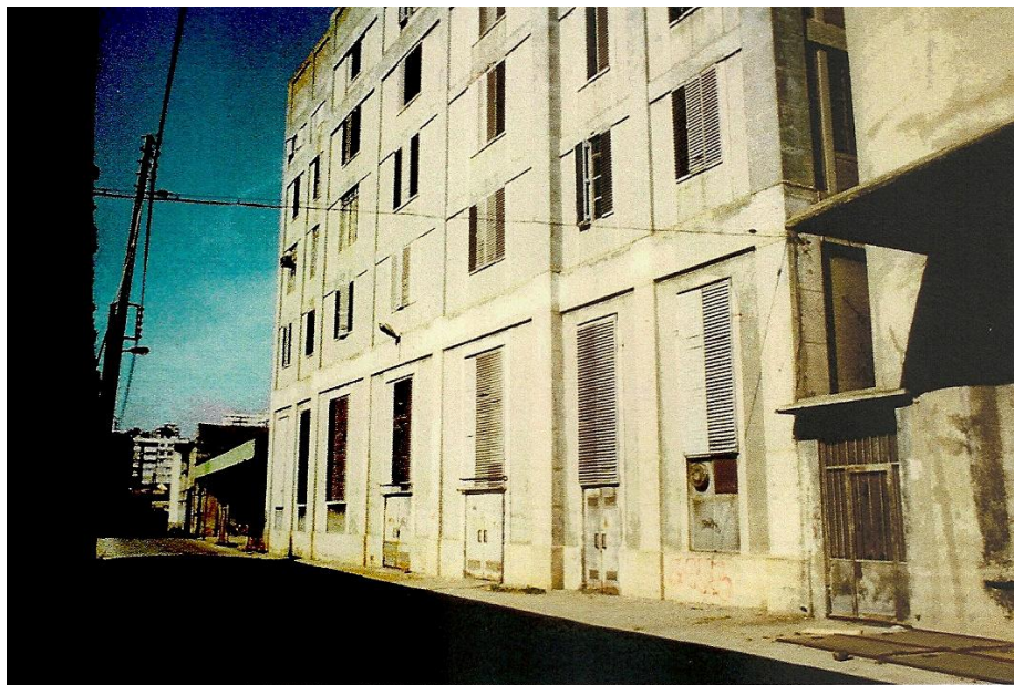
Foto 53 – Fachada oeste, vista no sentido S-N, 1997 (fonte: Direcção Regional de Cultura de Lisboa e Vale do Tejo, processo de classificação DRL-92/3(2); foto nº 326, rolo 3; autor: arq. José Russo)
