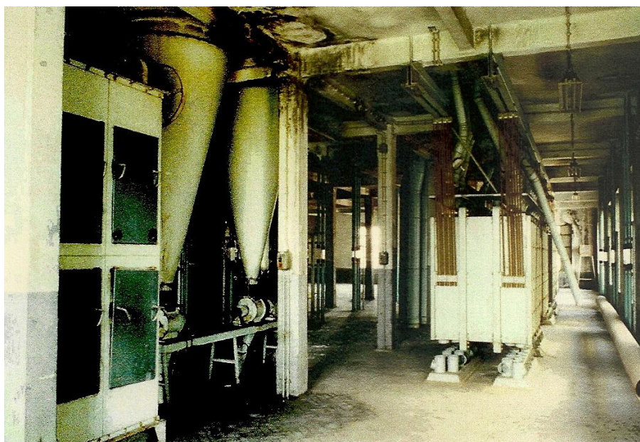
Foto 26 – Piso 4, vista longitudinal geral da ala norte, 1997 (fonte: Direcção Regional de Cultura de Lisboa e Vale do Tejo, processo de classificação DRL-92/3(2); foto nº 126, rolo 1; autor: arq. José Russo)
