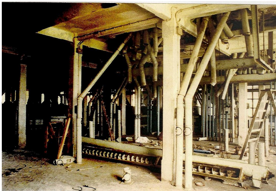
Foto 35 – Piso 3, vista oblíqua da ala sul (sentido SE-NO), 1997 (fonte: Direcção Regional de Cultura de Lisboa e Vale do Tejo, processo de classificação DRL-92/3(2); foto nº 206, rolo 2; autor: arq. José Russo)
