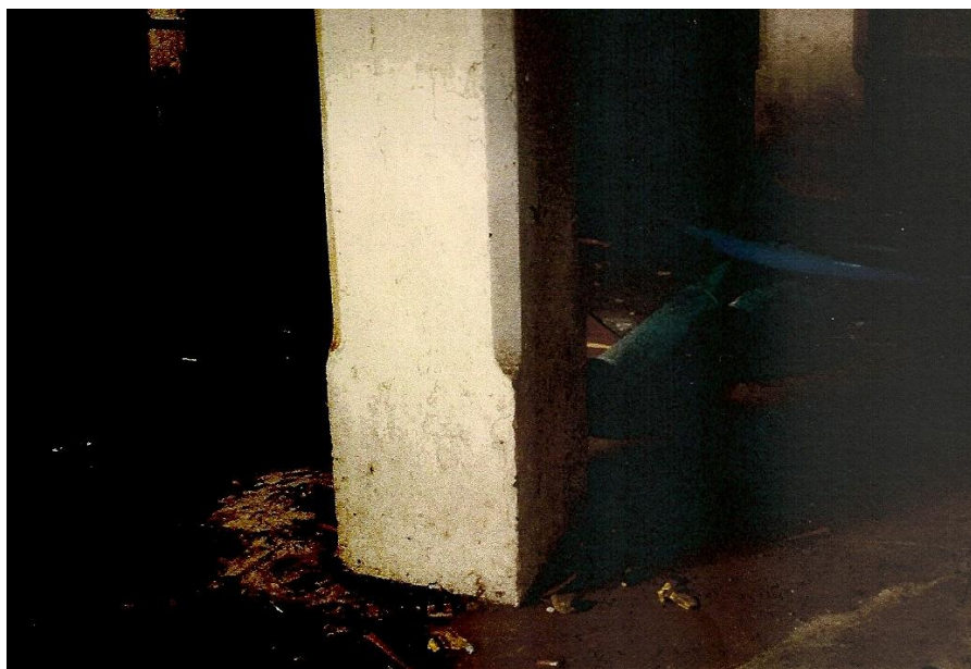
Foto 44 – Piso 0, ala norte 22 , base de pilar, 1997 (fonte: Direcção Regional de Cultura de Lisboa e Vale do Tejo, processo de classificação DRL-92/3(2); foto nº 227, rolo 2; autor: arq. José Russo)
