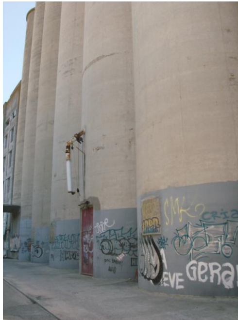
Foto 17 – Porta “vermelha”, porta principal dos silos, Rua Manuel José Gomes; fachada principal dos silos a partir do assoreamento do estuário, Agosto 2010 (Autora: Conceição Toscano)
