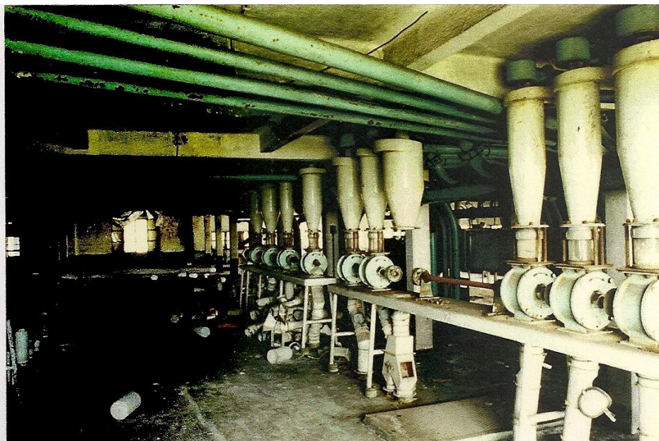
Foto 18 – Piso 5, vista longitudinal da ala norte (sentido este-oeste), 1997 (fonte: Direcção Regional de Cultura de Lisboa e Vale do Tejo, processo de classificação DRL-92/3(2); foto nº 113, rolo 1; autor: arq. José Russo)
