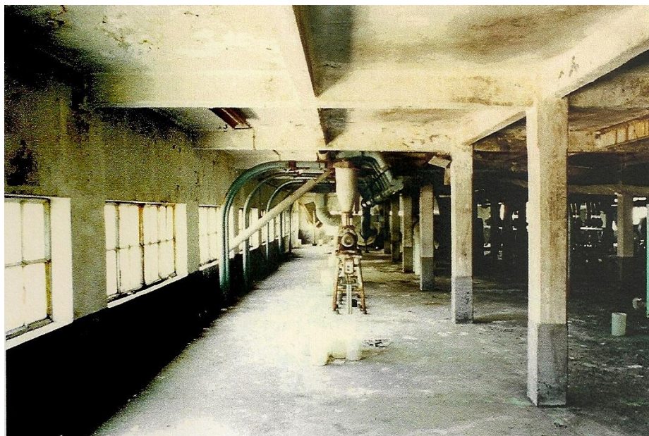
Foto 19 – Piso 5, vista longitudinal ao longo da ala norte (sentido oeste-este), 1997 (fonte: Direcção Regional de Cultura de Lisboa e Vale do Tejo, processo de classificação DRL-92/3(2); foto nº 114, rolo 1; autor: arq. José Russo)
