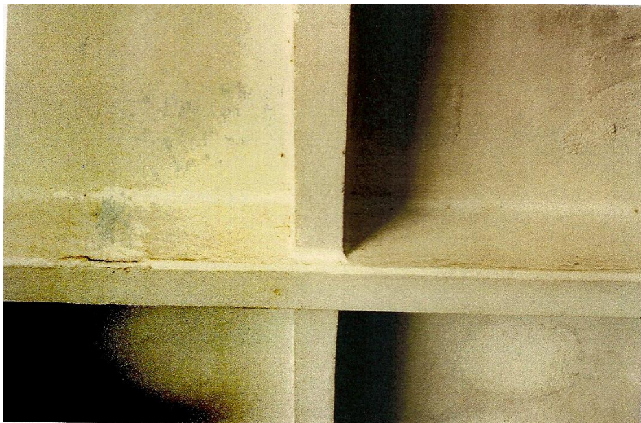
Foto 31 – Piso 4, ala norte, tecto, cruzamento de vigas, 1997 (fonte: Direcção Regional de Cultura de Lisboa e Vale do Tejo, processo de classificação DRL-92/3(2); foto nº 134, rolo 1; autor: arq. José Russo)
