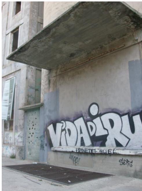
Foto 18 – Local das descargas dos cereais por parte dos camiões, após a “era dos batelões”; é visível na parede, acima do parapeito um buraco tapado – os camiões encostavam e viravam a carga para o interior dos silos; mais tarde foi feita a “fossa”, visível no chão, para descargas. A porta “verde” visível na foto entre as duas estruturas edificadas foi usada pelos trabalhadores até que os camiões vieram ocupar este espaço; nessa altura passaram a utilizar a porta “vermelha” (por aí acediam a “picar” o ponto, por exemplo), Agosto 2010 (Autora: Conceição Toscano)
