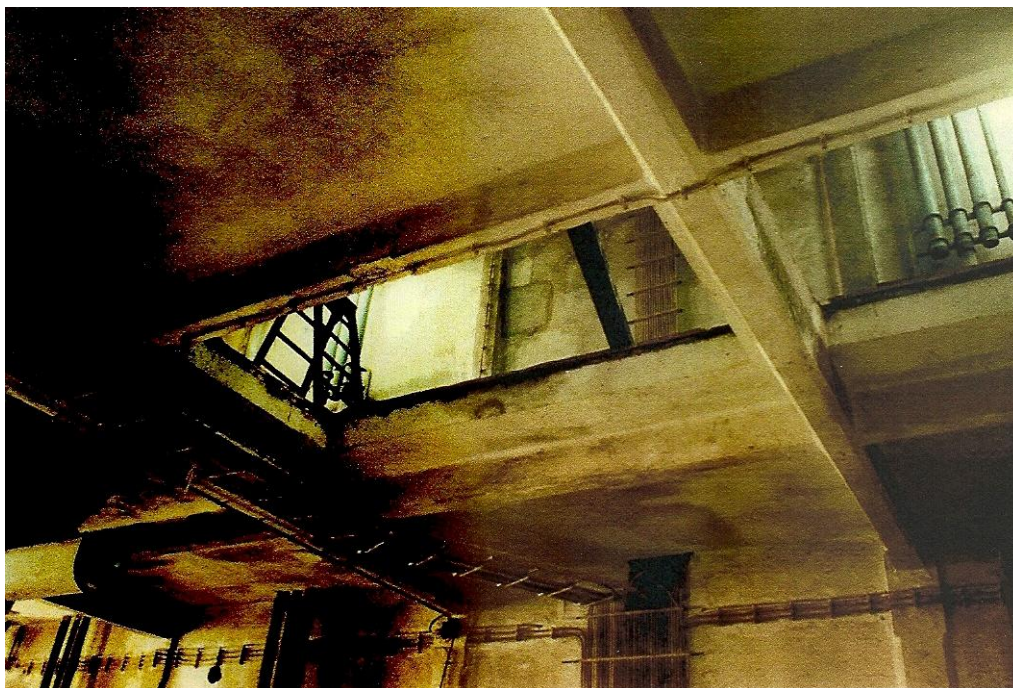
Foto 37 – Piso 3, ala norte, vista contra-picada sob recortes na laje, 1997 (fonte: Direcção Regional de Cultura de Lisboa e Vale do Tejo, processo de classificação DRL-92/3(2); foto nº 210, rolo 2; autor: arq. José Russo)
