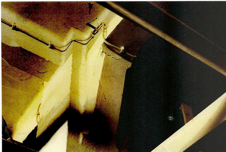
Foto 43 – Piso 0, ala norte, pilar e viga com escora de descarga, 1997 (fonte: Direcção Regional de Cultura de Lisboa e Vale do Tejo, processo de classificação DRL-92/3(2); foto nº 225, rolo 2; autor: arq. José Russo)
