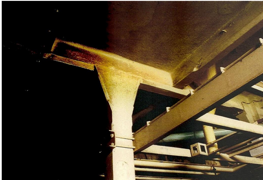
Foto 42 – Piso 0, ala norte, viga e pilar “capiteto”, 1997 (fonte: Direcção Regional de Cultura de Lisboa e Vale do Tejo, processo de classificação DRL-92/3(2); foto nº 223, rolo 2; autor: arq. José Russo)
