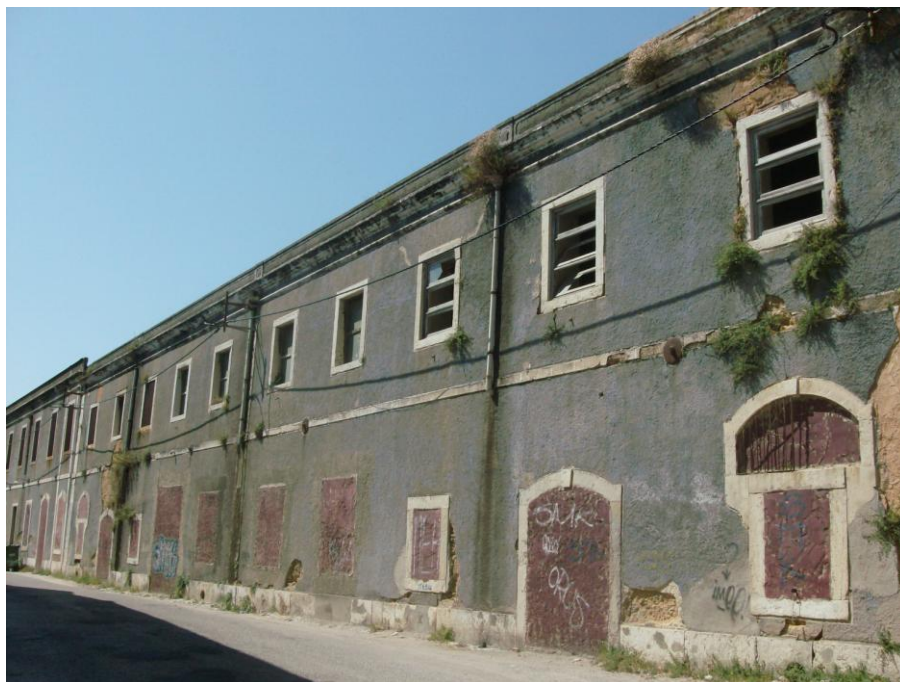
Foto 21 – Estrutura ocupada pelos seguintes serviços: no piso inferior, à direita, balneários de homens e mulheres e à esquerda a produção de bolachas; no piso superior, situava-se o refeitório, seguido do ensaie dos bombons, Agosto 2010 (Autora: Conceição Toscano)
