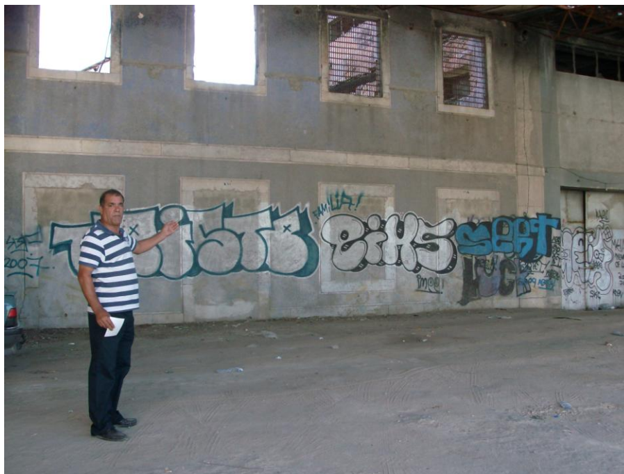
Foto 3 - Local do telheiro podendo ser vistas as portas de acesso ao armazém (agora fechadas); o operário Armindo foi aqui fotografado na década de 80 do século passado, junto das sacas da farinha, Agosto 2010 (Autora: Conceição Toscano)
