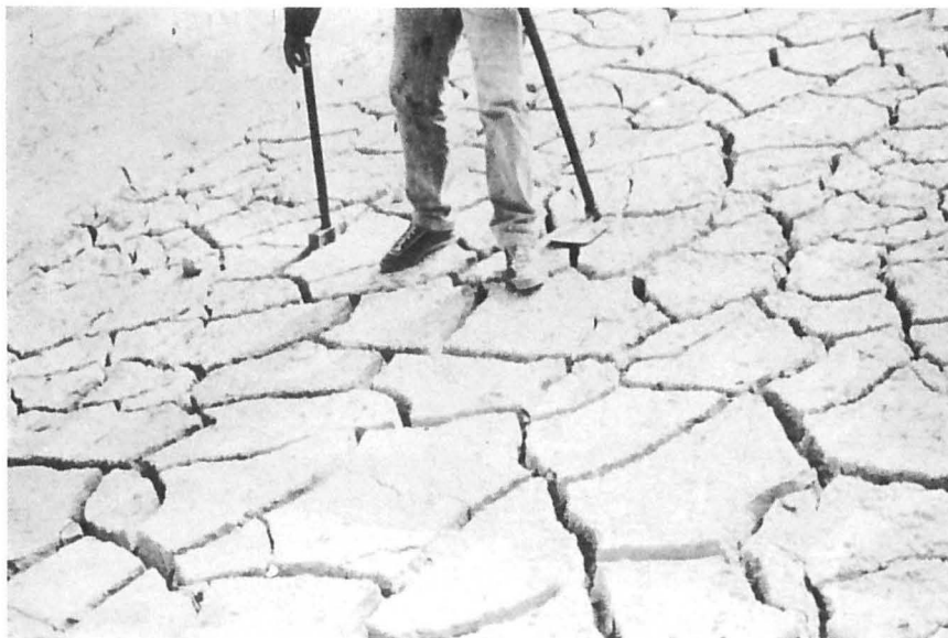
Foto 4 — Aspecto do fendilhamento na película silto-argilosa que cobre parte da superfície dos depósitos no braço da albufeira do rio Borralha (vista a jusante do perfil p.12 do levantamento topográfico da EDP).
