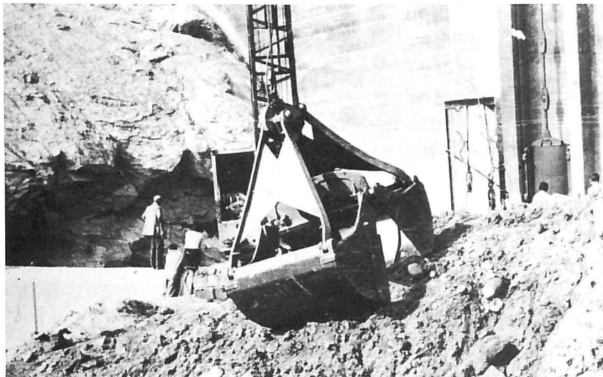
Foto 5 — Pormenor da limpeza da zona imediatamente a montante da barragem.
