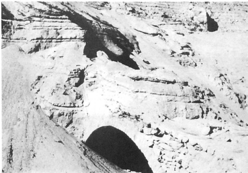
Foto 3 — Pormenor da ponte romana da figura anterior, parcialmente coberta.
