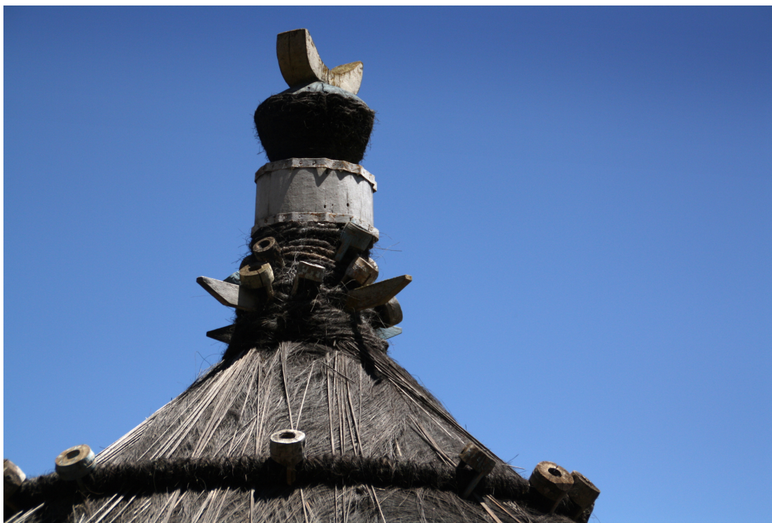
Foto 2 - Casa tradicional. No topo podemos ver a lua invertida e os motivos marítimos. Em redor, os círculos colocados nos pilares de sustentação e ao longo da casa, impedem a escalada aos ratos.
