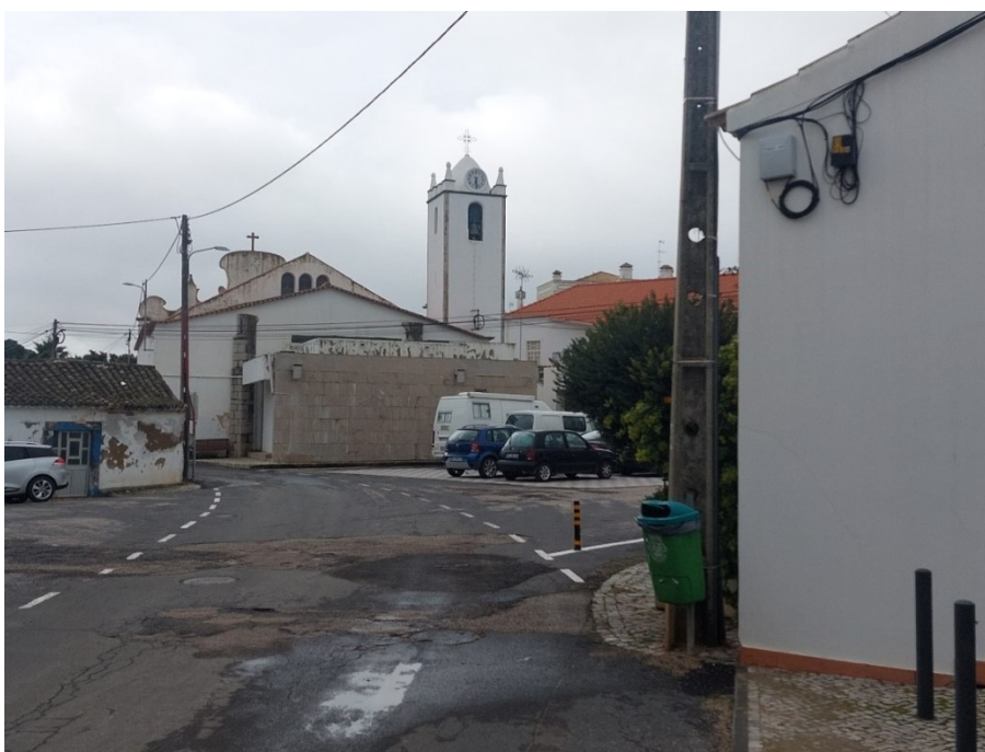
Figura I.19: Vista Norte da Igreja da Conceição de Tavira (Foto do Autor)
