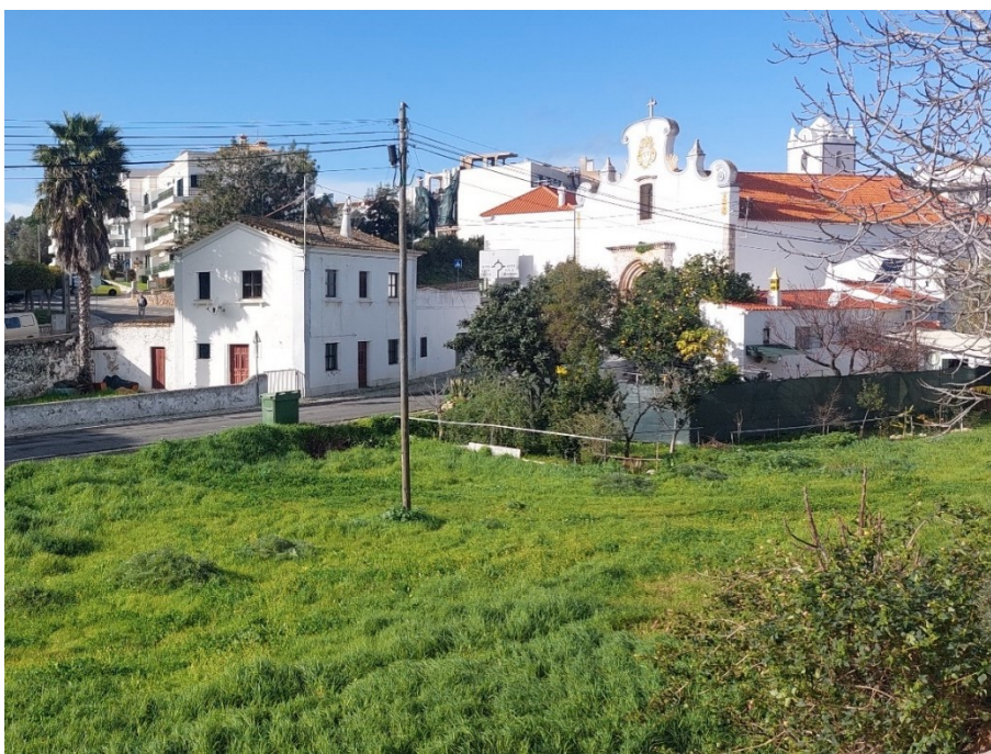
Figura I.1: Vista Geral da Igreja da Conceição de Tavira (Foto do Autor)
