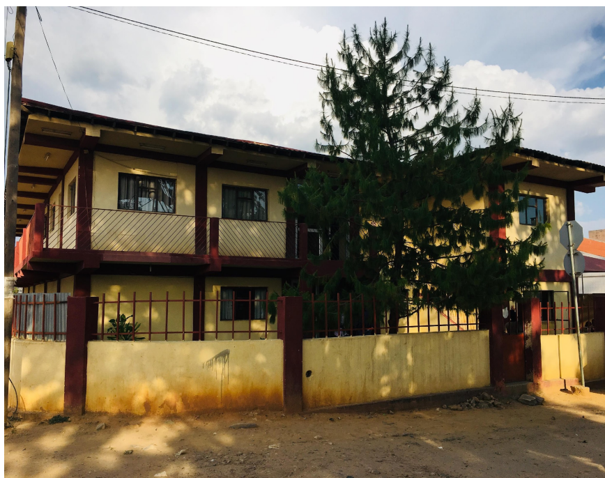
Figura 3.1 - Vista parcial do Complexo Escolar Cruzeiro do Sul
