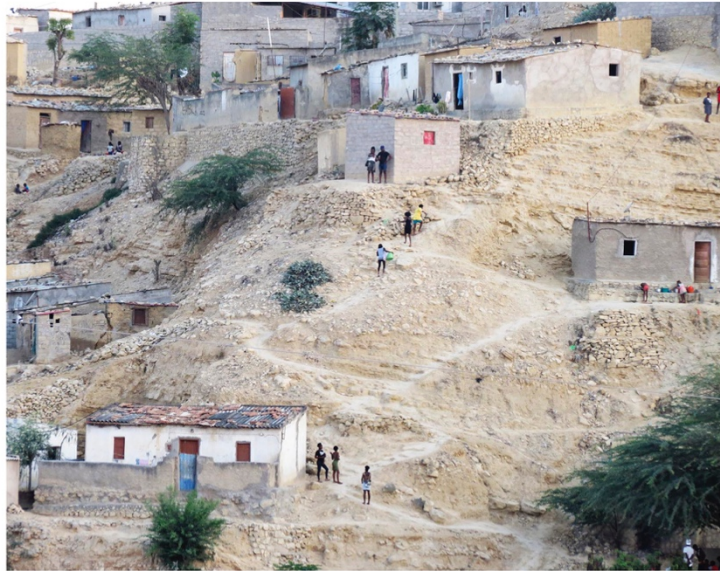
Figura: 5.82 Rua de dá acesso à casa das Oleiras
