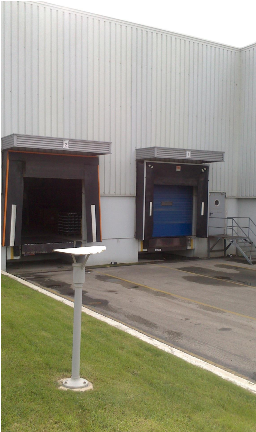
Figura 24 - Doca para expedição de material no armazém de expedição
