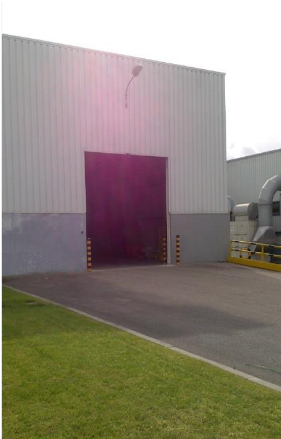
Figura 28 - Doca para recepção de material no armazém de recepção
