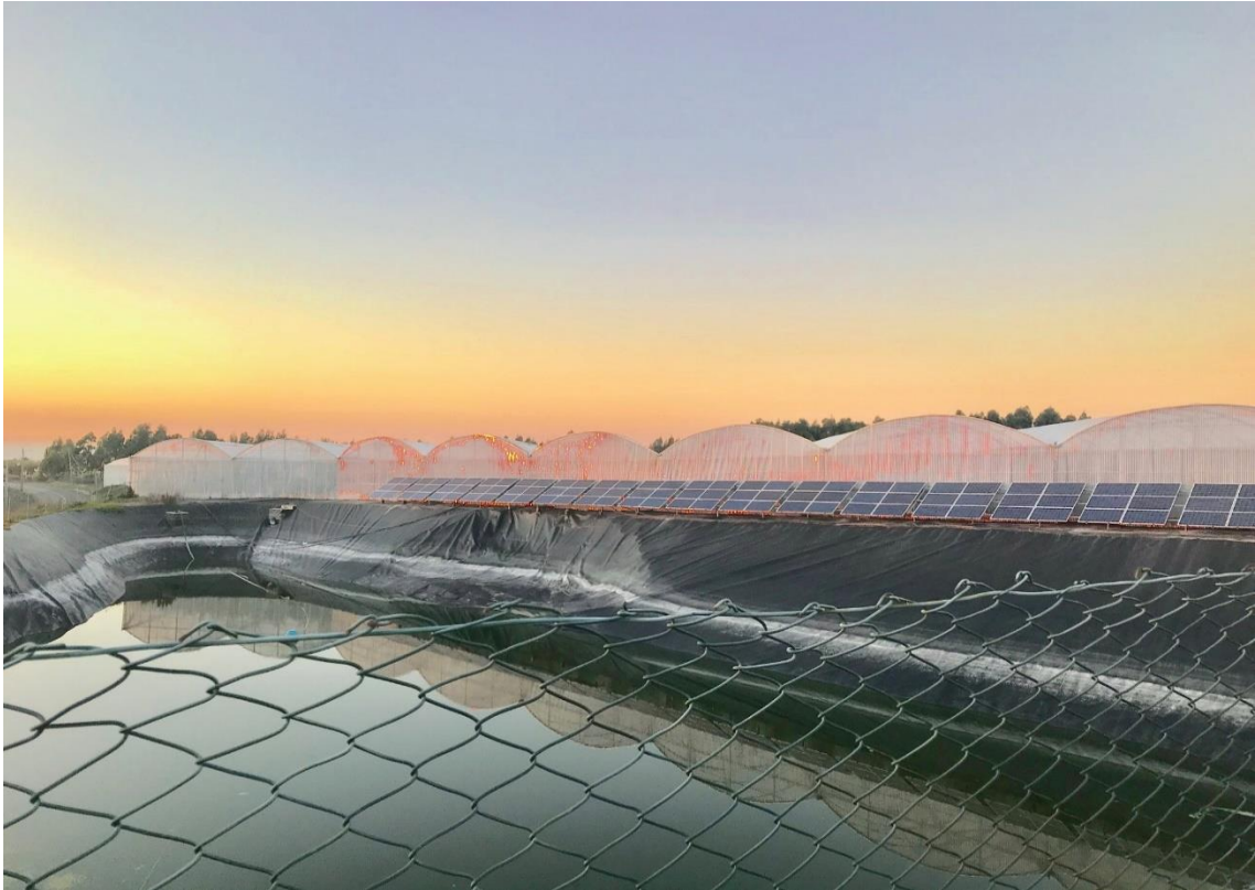
Figura 4.14. Lagoa e painéis de energia solar em espaço hortícola com cobertura (foto do próprio).
