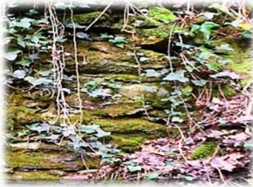
Fig. 17 Um dos muros antigos que se observa ao longo das margens da linha de água.
