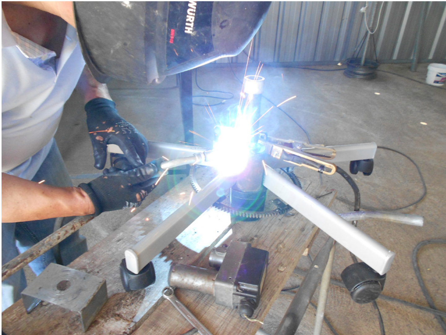
Processo construtivo - soldadura
