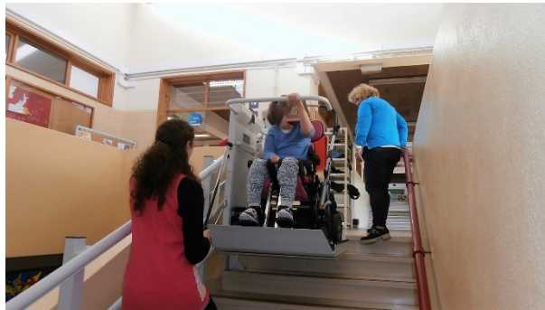
Acesso à BE utilizando a plataforma elevatória
