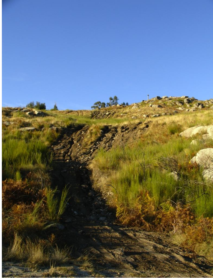
Fig. 37 - Derrubes do sistema defensivo – parte de muralhas e taludes artificiais do castro de Quires, na vertente Sul
