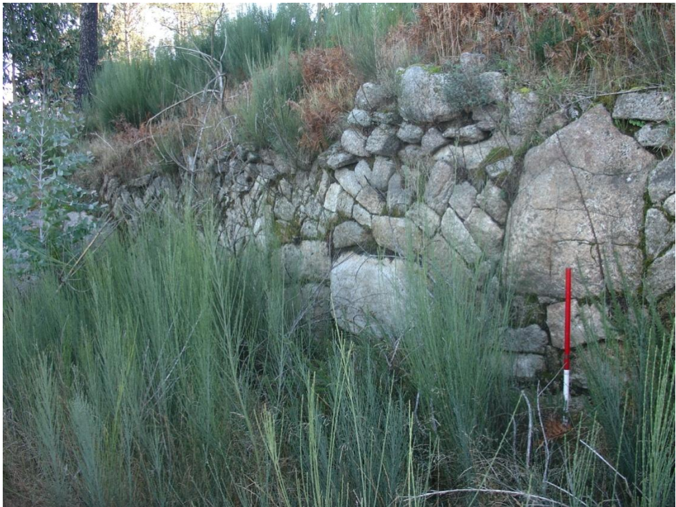
Fig. 4 - Tramo de muralha do castro de Arados
