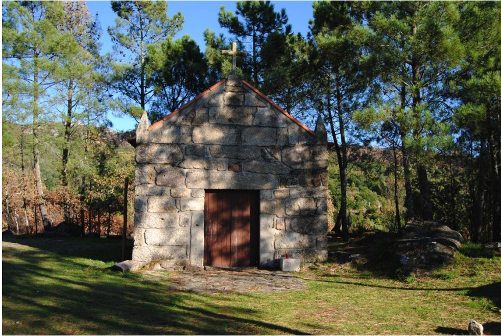
Fig. 42 - Capela de Santiago que dá o nome ao povoado, que se encontrava abandonado e que foi alvo de várias obras no final do Séc. XX
