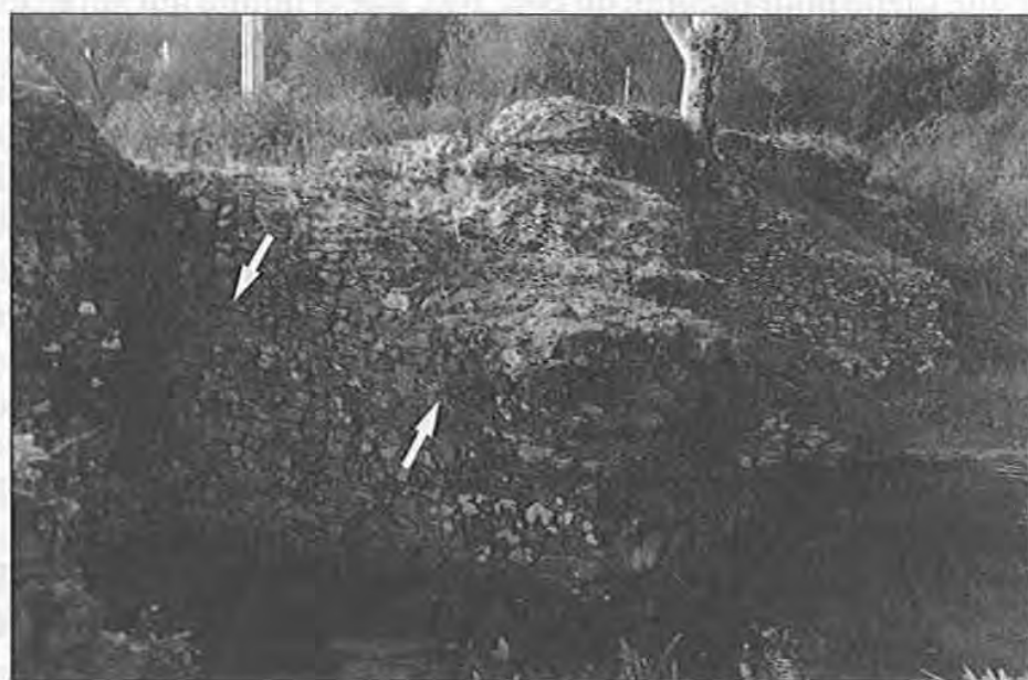
PHOT. 14. — Barrage de Grândola. Contrefort, mettant en évidence les deux phases de construction ; les flèches signalent la zone de séparation des deux phases.
