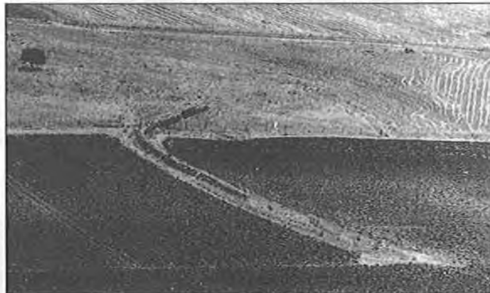
PHOT. 8. — Barrage de Muro dos Mouros (Serpa). Photo aérienne oblique, vue d'aval.
