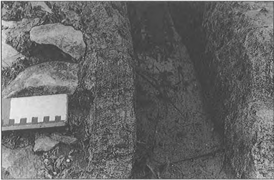
PHOT. 21. — Barrage de Vale Tesnado. Tronçon couvert du canal de Cerro da Vila.
