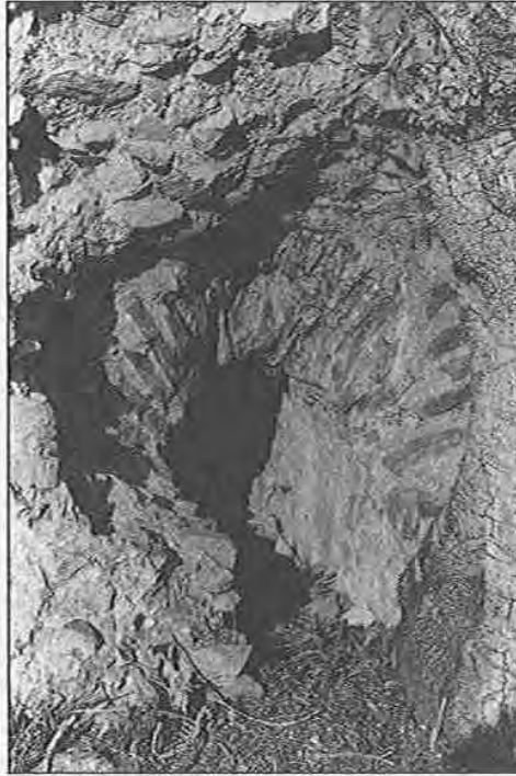
PHOT. 10. — Barrage de Pisões (Beja). Détail de la vidange de fond, avec voûte en brique, cachée à droite par un tronc d'arbre.
