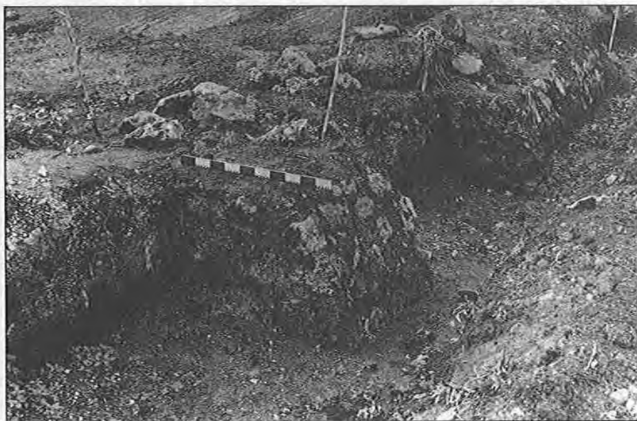
PHOT. 20. — Barrage de Vale Tesnado. Contreforts d'amont, dans la zone centrale.
