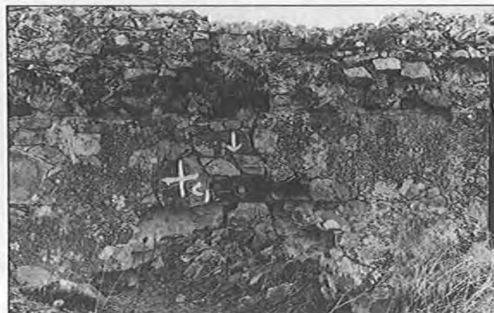
PHOT. 9. — Barrage de Muro dos Mouros (Serpa). Parement d'amont, où l'on peut observer un tuyau en céramique sur la sortie de la ligne d'eau actuelle.
