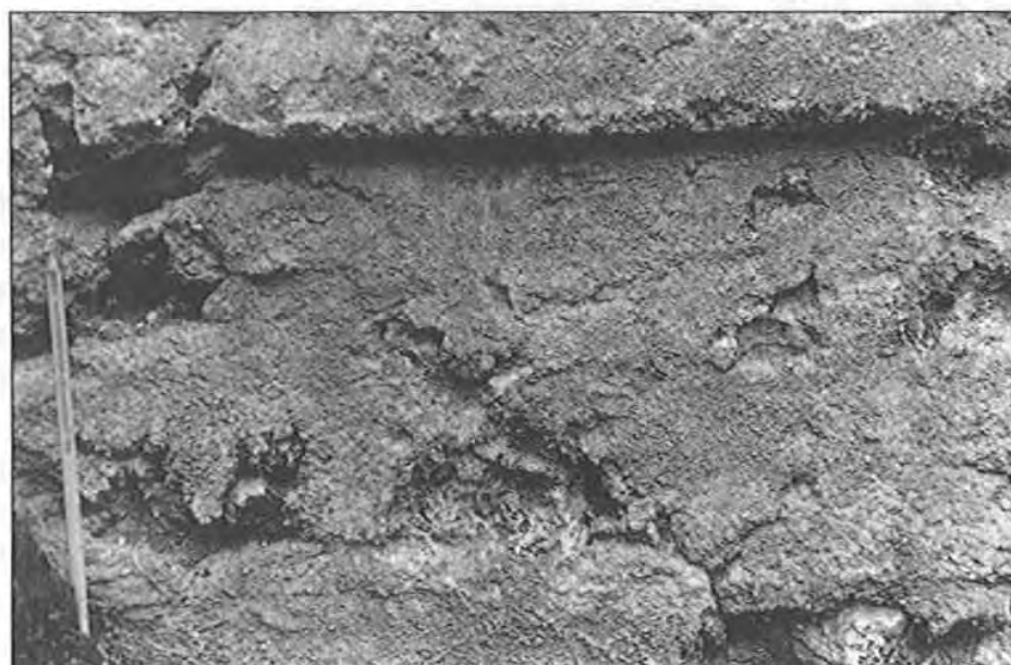
PHOT. 17. — Barrage de Ponte dos Mouros. Vue du parement d'amont, où l'on reconnaît l'empreinte d'une planche en bois de coffrage.
