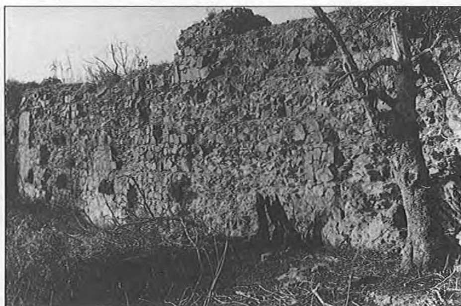
PHOT. 6. — Barrage de Pisões (Beja). Vue d'aval, montrant le revêtement extérieur partiellement conservé.
