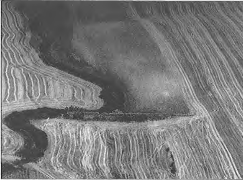
PHOT. 2. — Barrage de Moralves (Elvas). Photo aérienne oblique, vue d'aval. La ligne d'eau a été déviée pour contourner l'extrémité droite.
