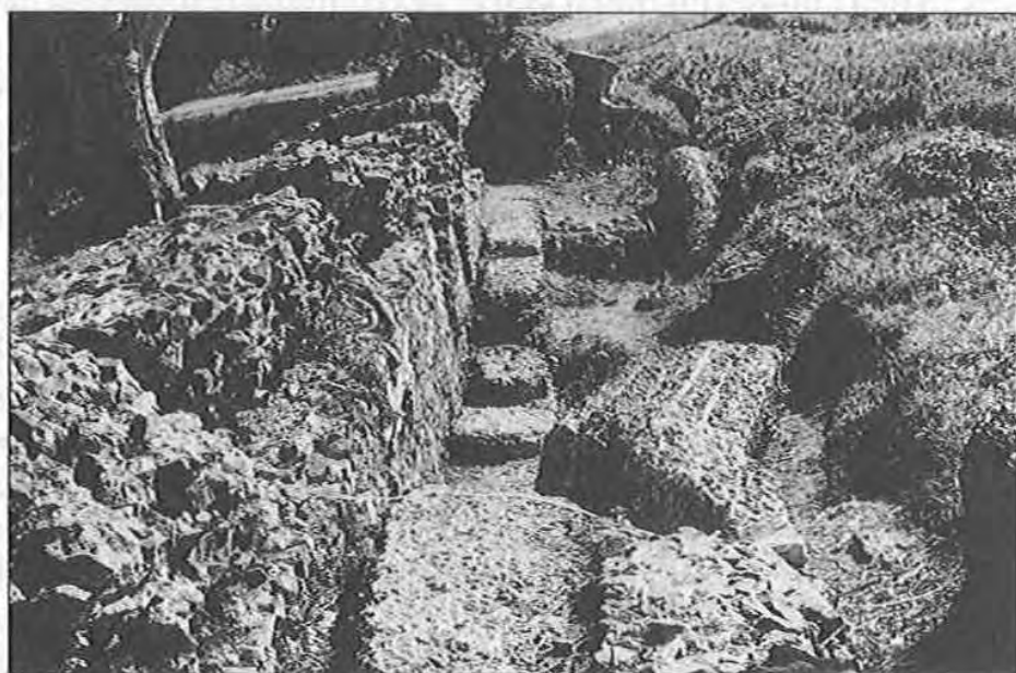
PHOT. 13. — Barrage de Grândola. Vue d'amont obtenue de la rive gauche, montrant les trois murs juxtaposés et un bloc du mur intermédiaire tombé.
