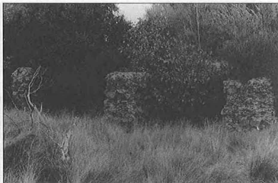
PHOT. 5. — Barrage de Muro da Prega (Beja). Vue d'aval, avec ses contreforts.
