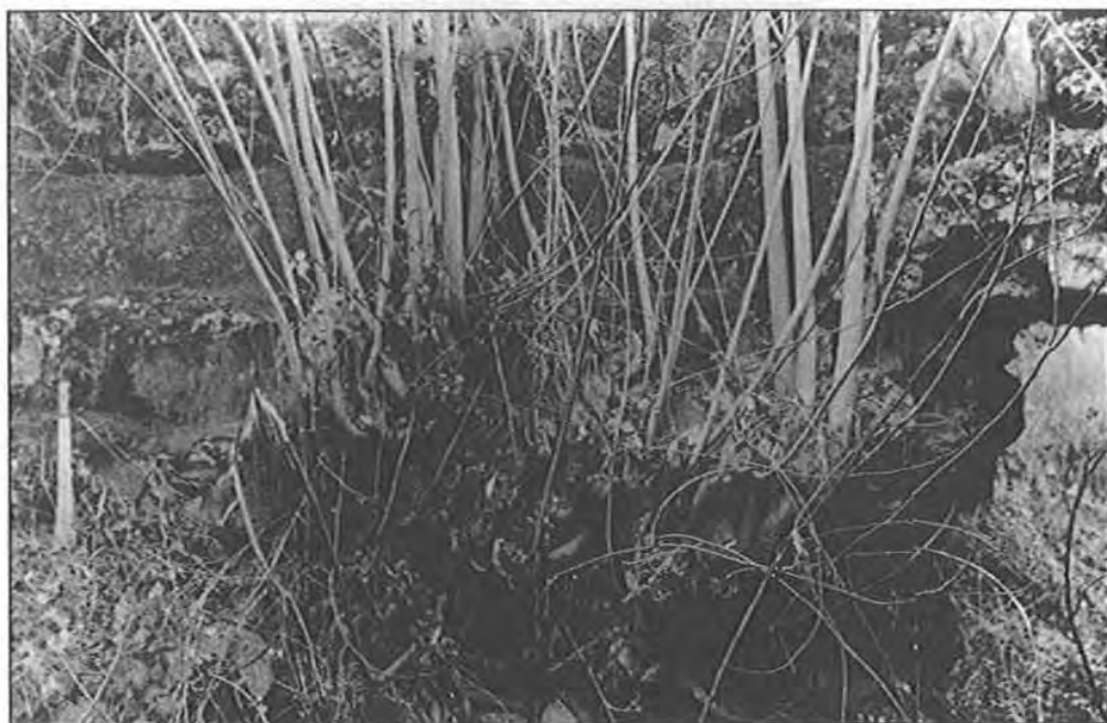
PHOT. 11. — Barrage de Cano. Vue d'amont, montrant du côté droit la trouée au niveau du talweg et, à gauche, une partie du revêtement en opus signinum .
