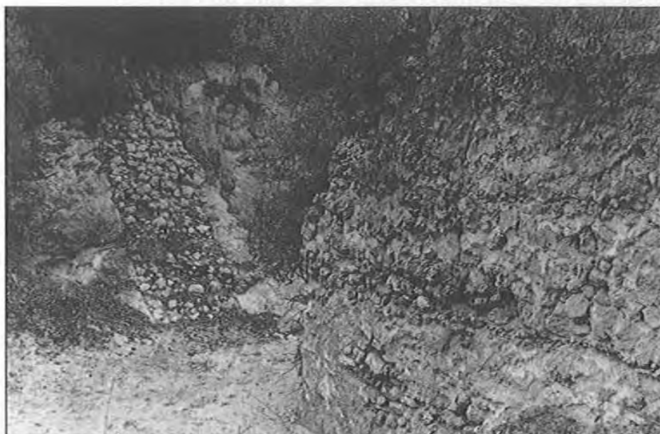
PHOT. 16. — Barrage de Ponte dos Mouros. Vue du parement d'amont, où l'on note la fondation de l'extrémité de la rive gauche.
