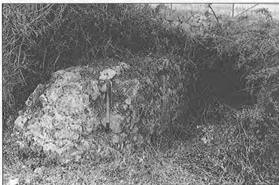
PHOT. 18. — Barrage d'Espiche. Vue du parement amont du tronçon encore visible (rive gauche).
