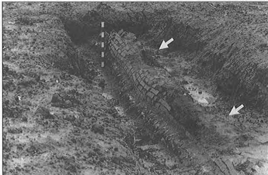
PHOT. 22. — Barrage de Vale Tesnado. Les flèches indiquent le revêtement en opus signinum , supportant un dépôt calcaire de grande épaisseur.
