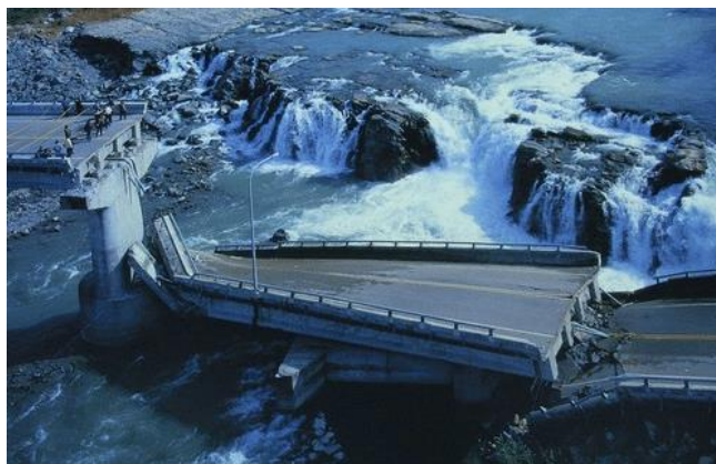
Figura 14 – Rotura superficial resultante do sismo de 1999 em Ji-Ji, Taiwan. O levantamento da parte montante do rio destruiu a ponte e criou uma cascata com cerca de 6 m de altura. Fonte: https://www.pnsn.org/outreach/earthquakehazards/surface-rupture .
