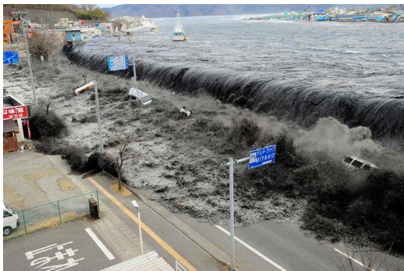
Figura 20 – Tsunami gerado pelo sismo de 11 de março de 2011, galgando paredão de proteção contra tsunamis com 10 m de altura (Miyako, Japão). Fonte: https://www.flickr.com/photos/ophelia_jane_julia/5534414080 .
