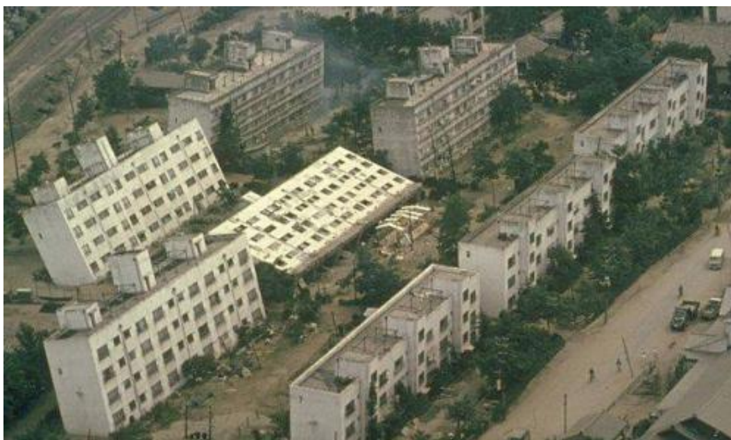
Figura 18 – Efeito da liquefação do terreno após o sismo de 1964, em Niigata, Japão Fonte: https://upload.wikimedia.org/wikipedia/commons/4/42/Liquefaction_at_Niigata.JPG .
