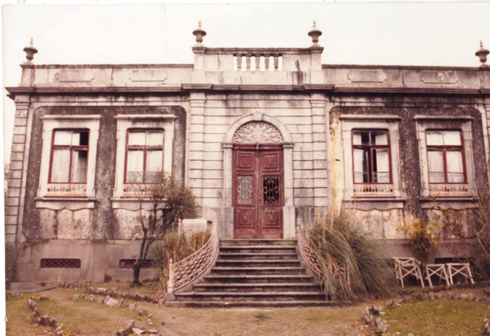
Figura 4.2-53. Edifício da GNR Ruína (Foto A. B.M.P.F)
