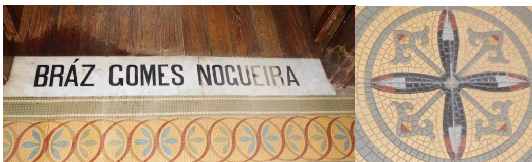
Figura 4.2-18. Chão do hall de entrada (Mosaico árabe e placa de mármore com a inscrição do nome do proprietário)
