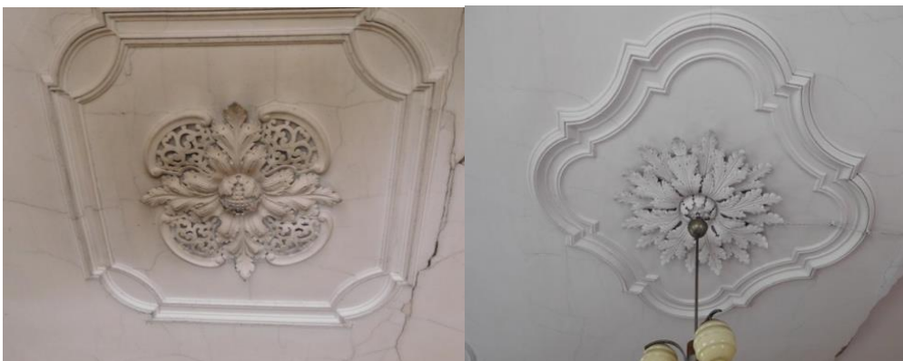
Figura 4.2-7. Tetos da escadaria e da sala de jantar
