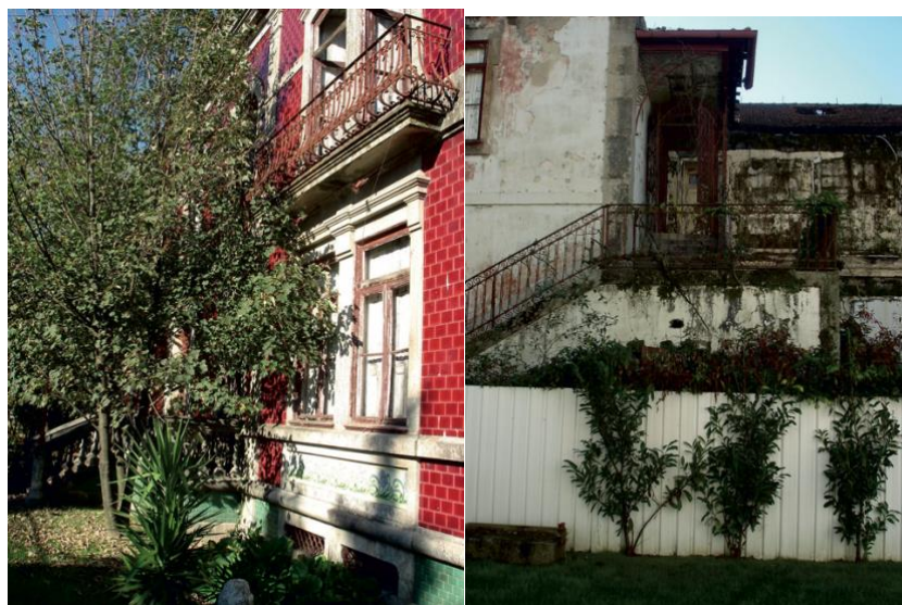
Figura 4.2-50. Degradação da Vila Maria (Foto arq. Sílvio Silva)
