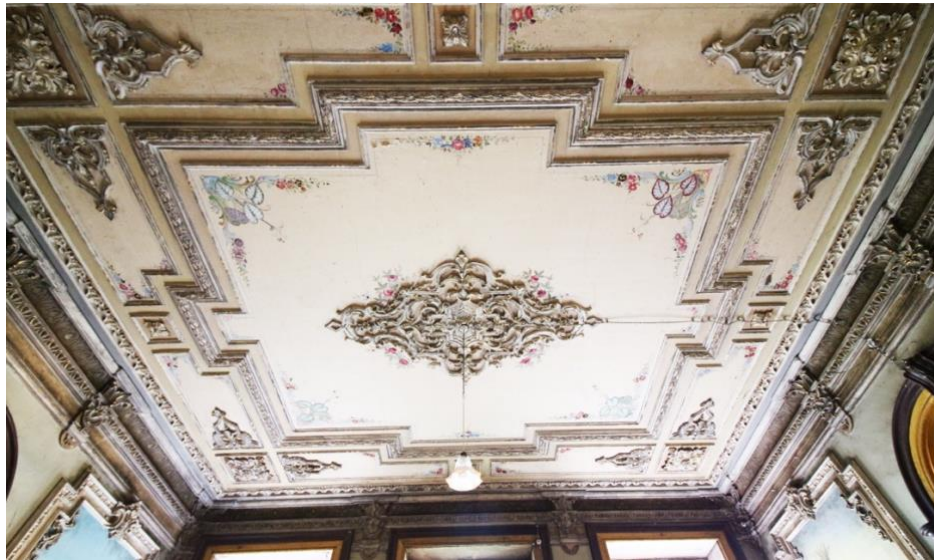
Figura 4.2-36. Teto em estuque da sala de visitas
