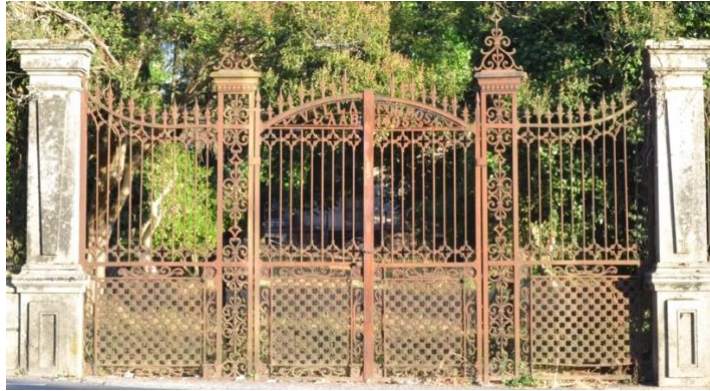
Figura 3.2-2. Portão Principal da Vila Formosa
