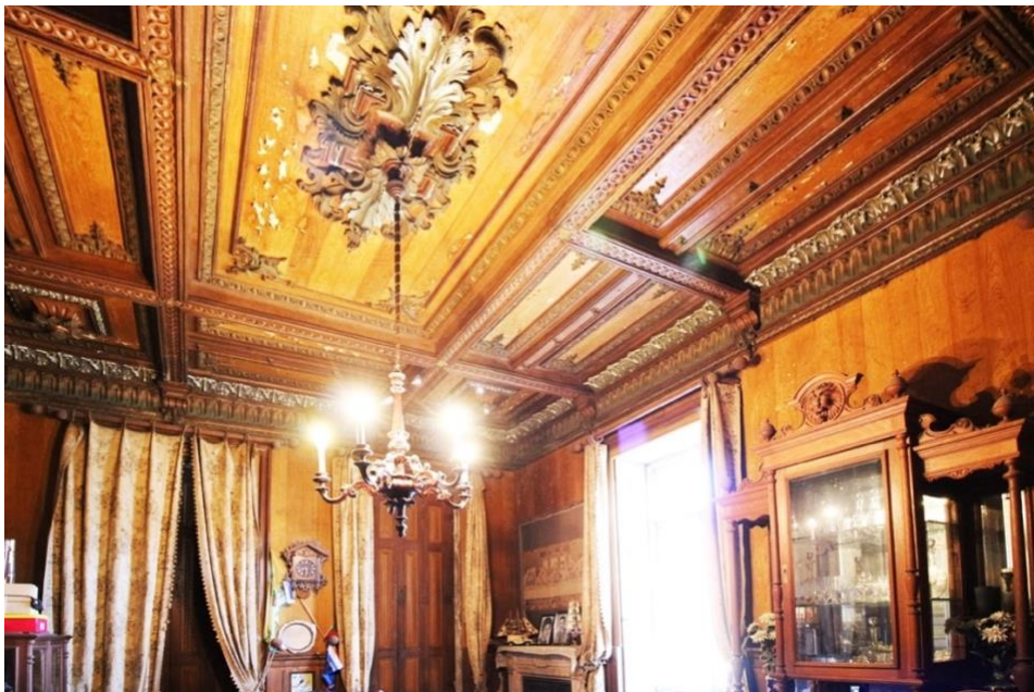
Figura 4.2-39. Teto em estuque a imitar madeira da sala de jantar
