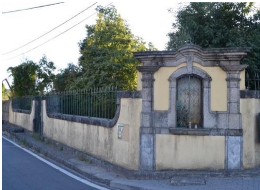
Figura 4.2-8. Muro de vedação
